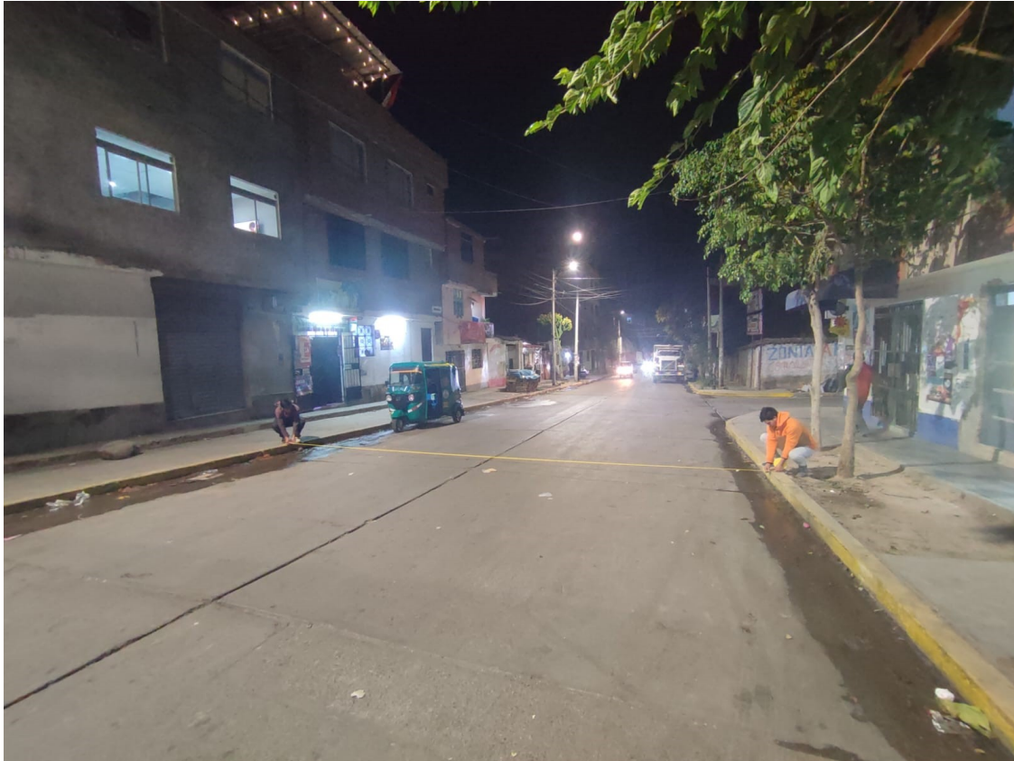
Figura 28 Medición de calzada en el Jr. Agustín Gamarra
