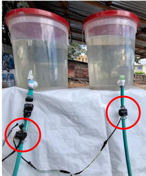
Instalación del sensor de flujo de agua 1/2" YF-S201
