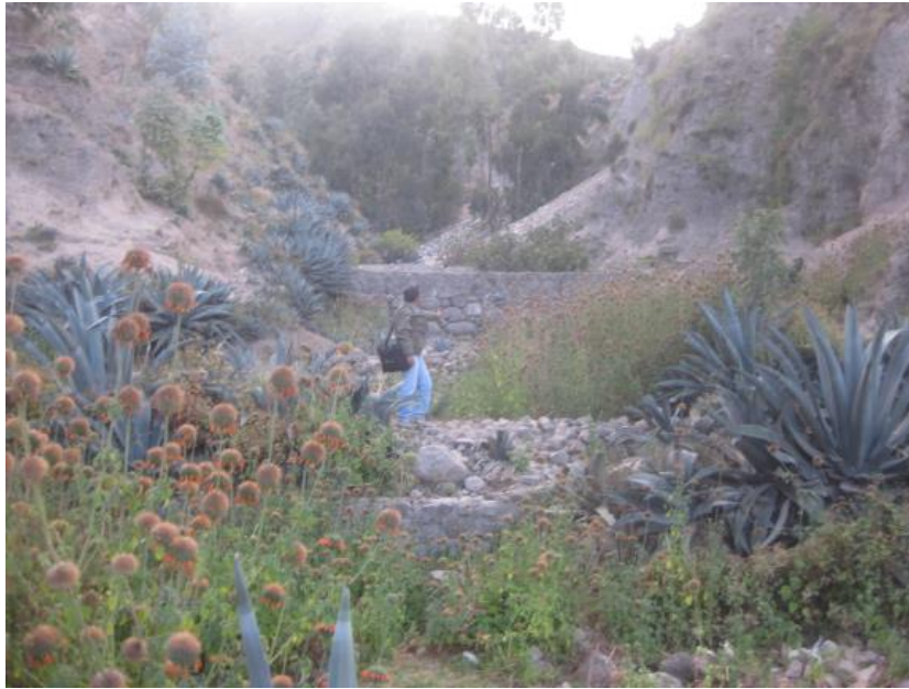
Figura N° 4.3: Diques de mampostería de piedra
