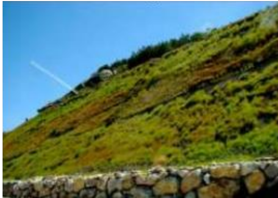
Figura N° 2.22: Terraplén ya estabilizado
