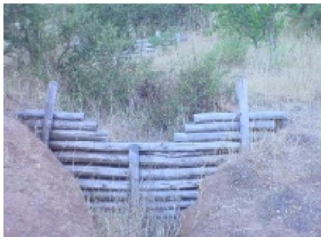
Figura N° 2.12: Diques de rollizos de madera
