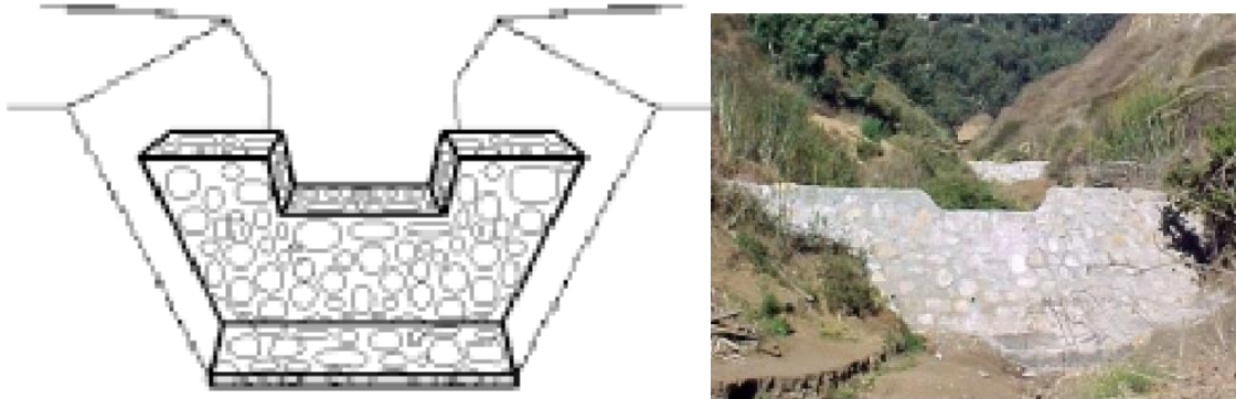
Figura N° 2.10: Diques de piedra con cementeo (mampostería hidráulica)
