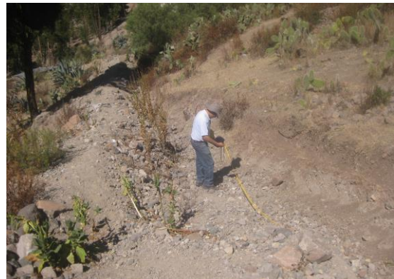
Figura N° 4.2: Canal sin revestir
