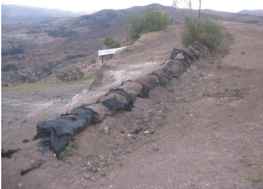
Figura N° 4.4: Zanja de coronación
