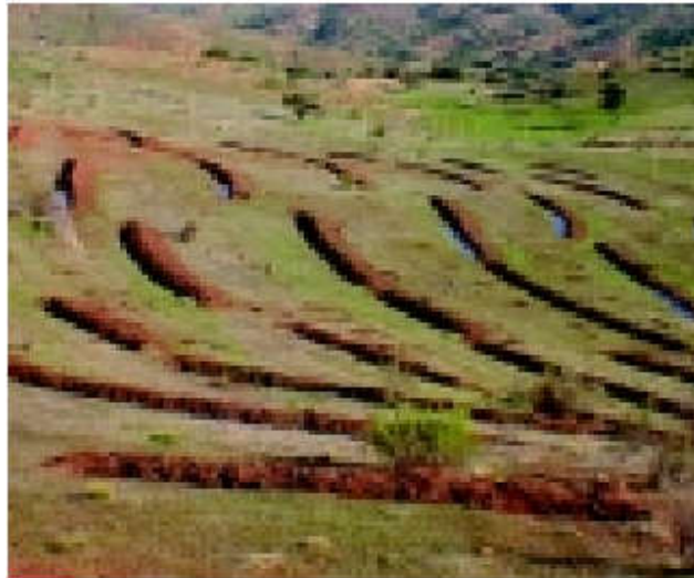
Figura N° 2.18: Zanjas de infiltración
