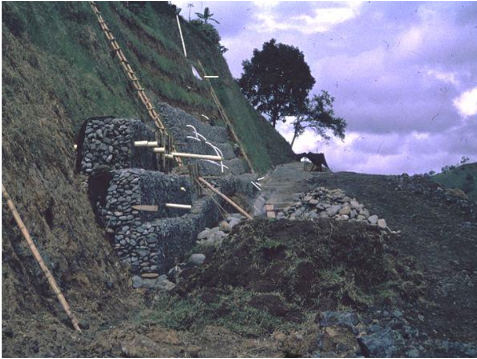
Figura N° 2.3: Construcción de gaviones
