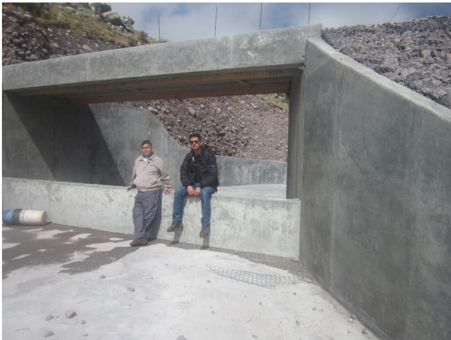
Figura Anexo 1- 20 Aliviadero de la represa carnicería
