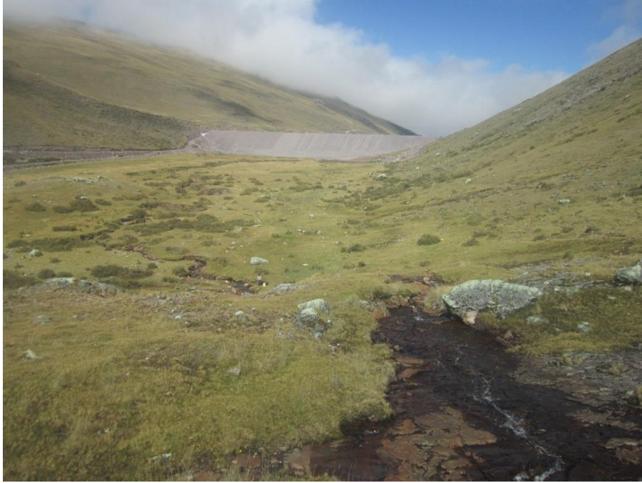
Figura Anexo 1- 17 Represa Carnicería en la quebrada Lluncuna
