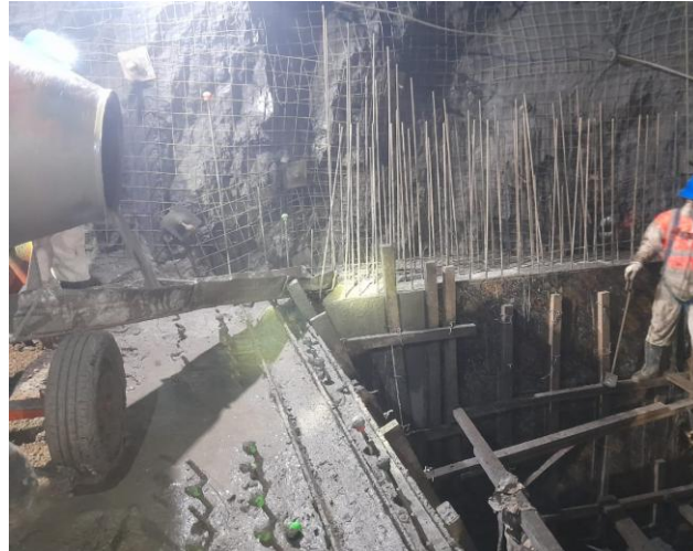
Nota. Vaciado de concreto en el anillo de la Ch-2 Nv. 710.
