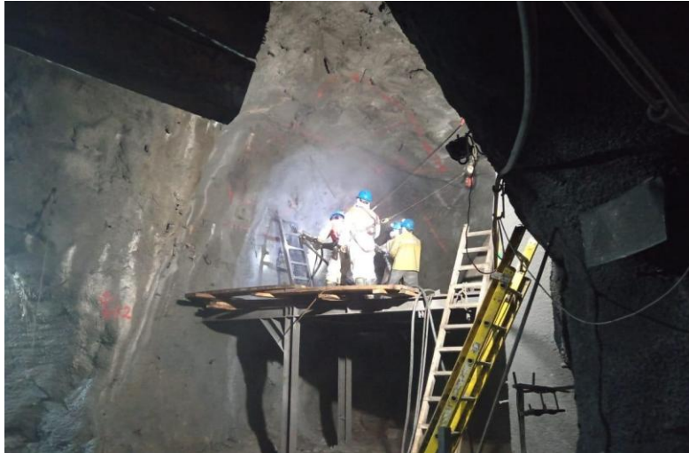
Nota. Inicio de la perforación en la Ch-2
