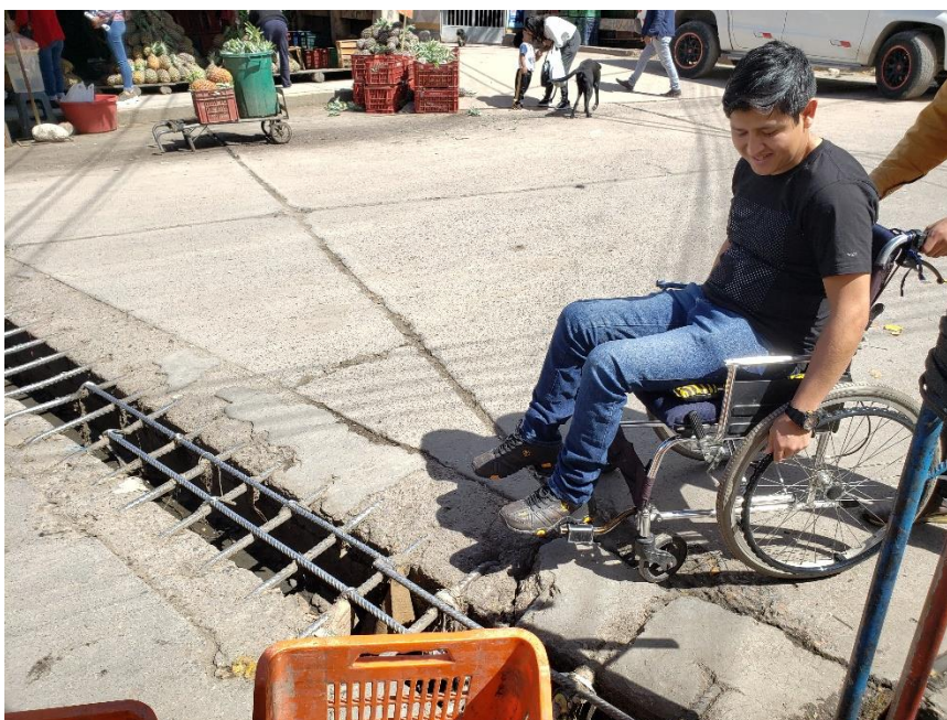
Figura 6. Barrera arquitectónica en calzadas
