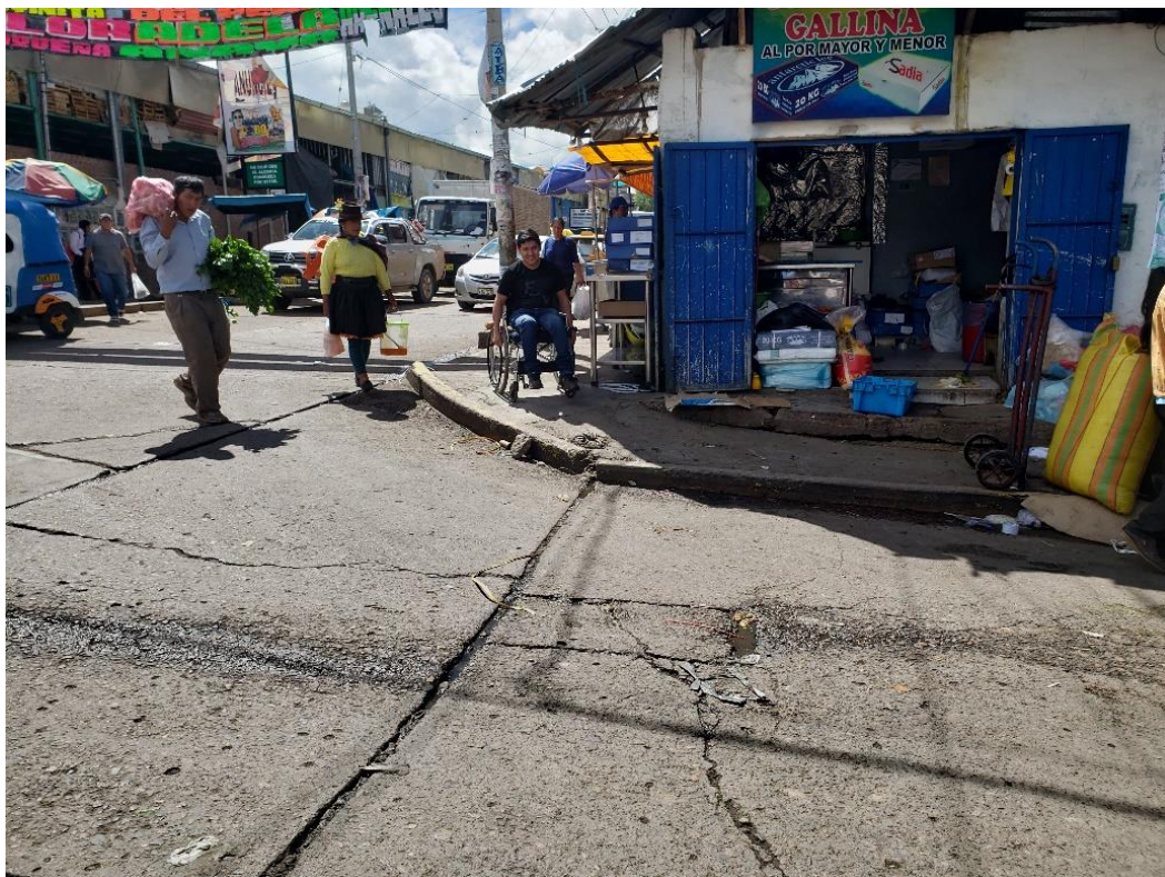
Figura 23. Obstáculos en veredas que impiden el tránsito de PCD
