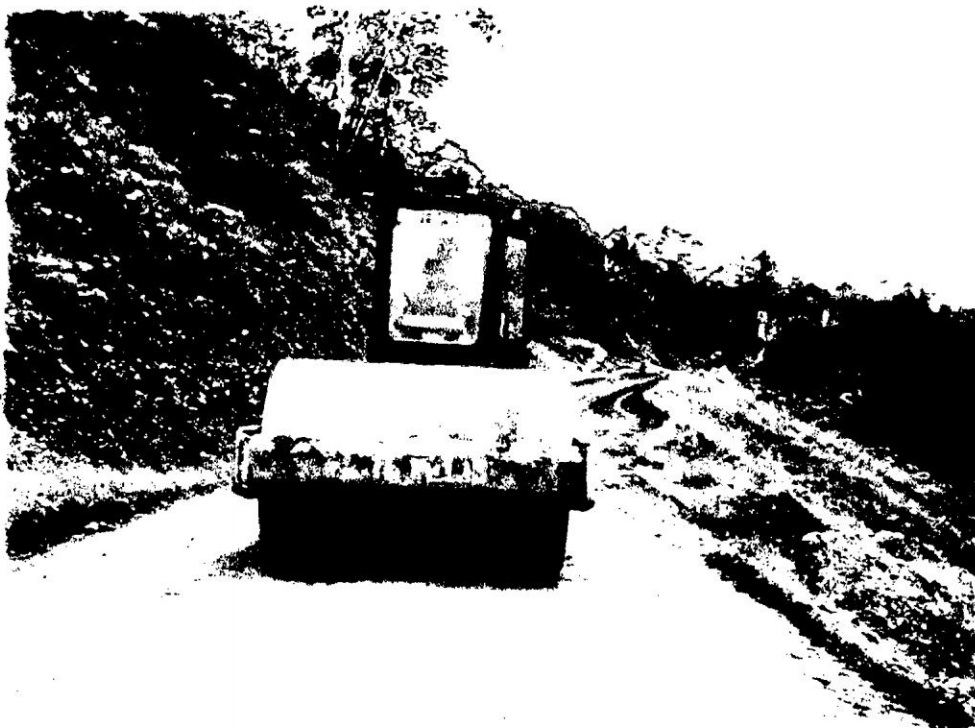
Foto N° 2.8.- Compactación de la capa de afirmado
