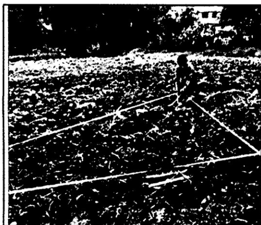
Señalización del terreno
