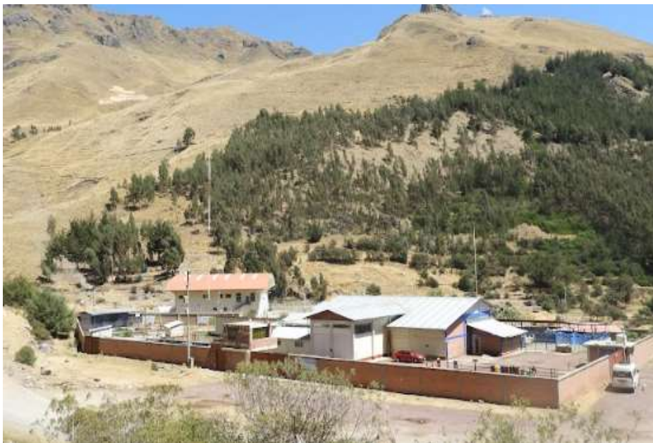
Anexo 1. Vista panorámica del Camal Municipal de Huancavelica, donde se recolectaron las muestras de fetos.
