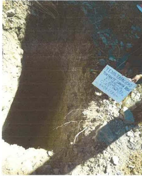
Figura 05. Excavación calicata C – 05, Coordenadas 583501.05 E/ 8549042.82 N, Prof. 0.00 – 3.00m
