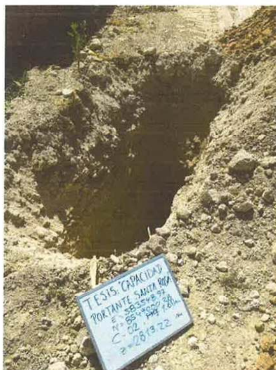
Figura 02. Calicata C – 02, Coordenadas 583548.97 E/ 8549000.28 N, Prof. 0.00 – 1.60 m
