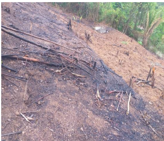
Anexo 5.1. Limpieza del terreno
