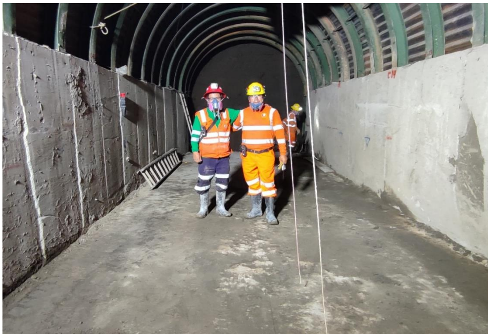
Anexo 10: Inspección por el Ing. jefe de guardia de la UMCH.
