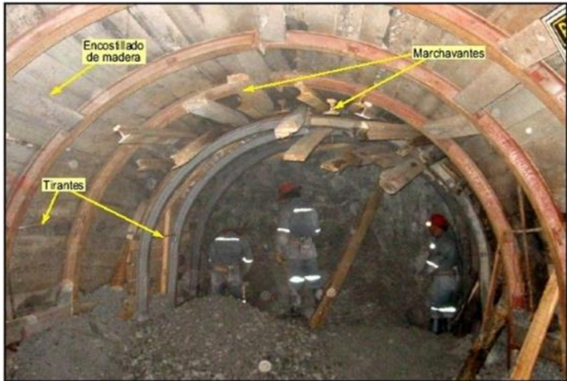
Imagen 6: Partes de las cimbras metálicas. Fuente: Imagen descargada del internet.
