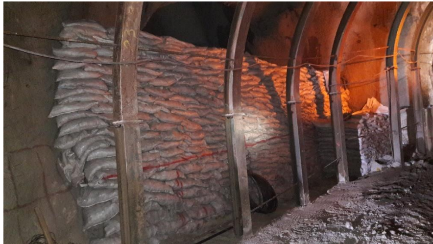
Imagen 5: Encostillado con bolsacreto en las cimbras.
