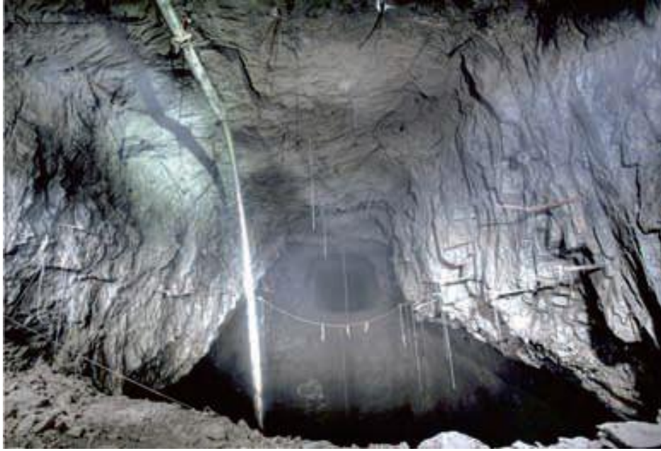
Imagen 10: Relleno de pasta de cemento a la zona de un tajo.
