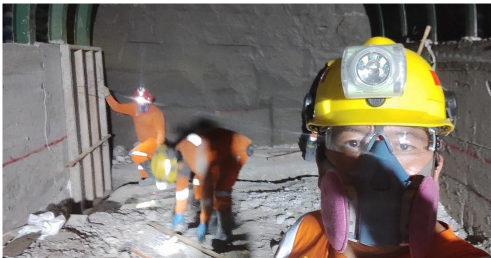
Anexo 14: Proceso de desencofrado los muros.
