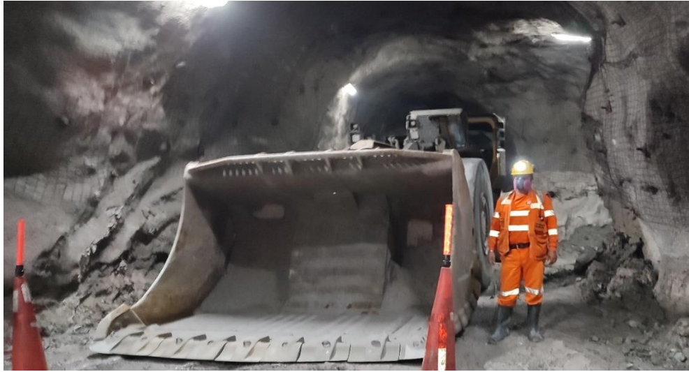
Anexo 9: Equipo Scoop utilizado en la limpieza de relleno.
