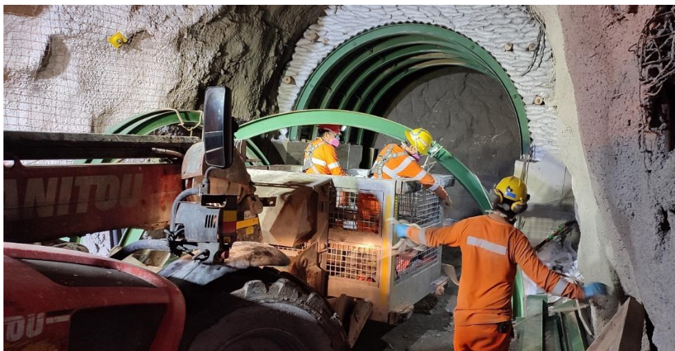
Anexo 15: Proceso de traslado del arco de la cimbra.
