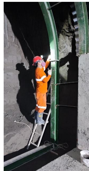
e. Instalación del poste y solera
