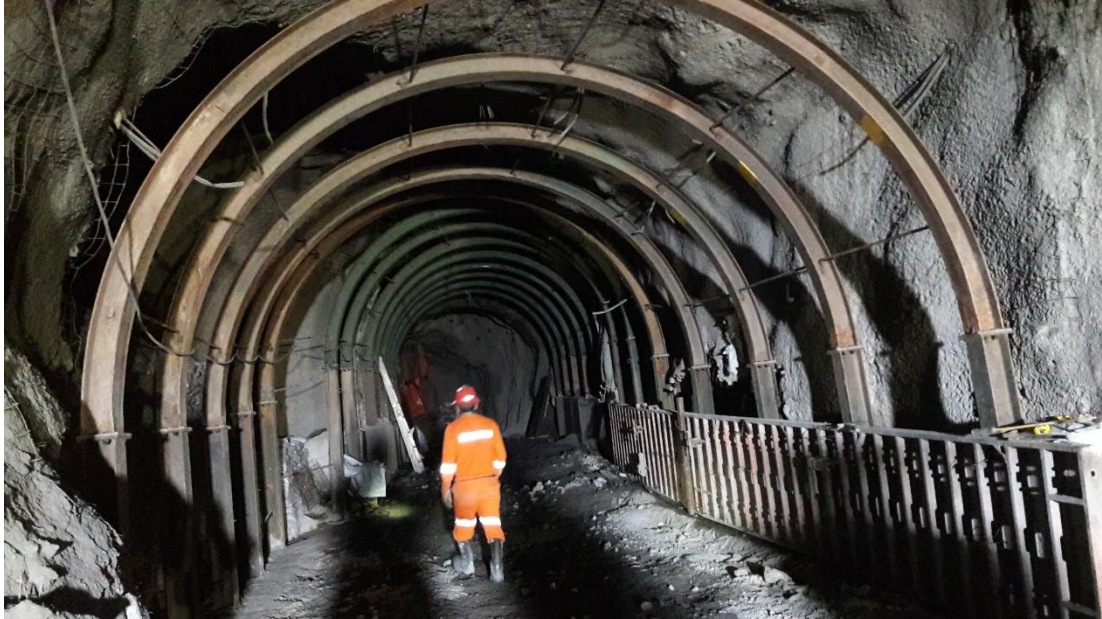
Imagen 8: instalación de cimbras metálicas en la Rp 3420.
