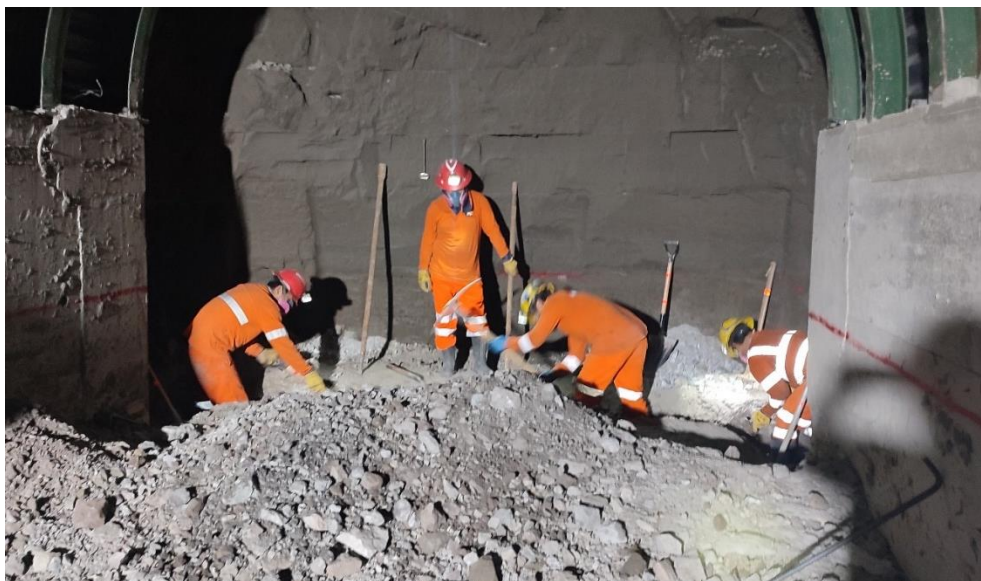
Anexo 13: Proceso de picado, limpieza y colocado de solera y poste.
