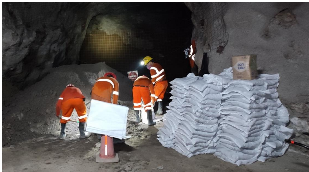
Anexo 12: Preparación de los bolsacreto para las cimbras.
