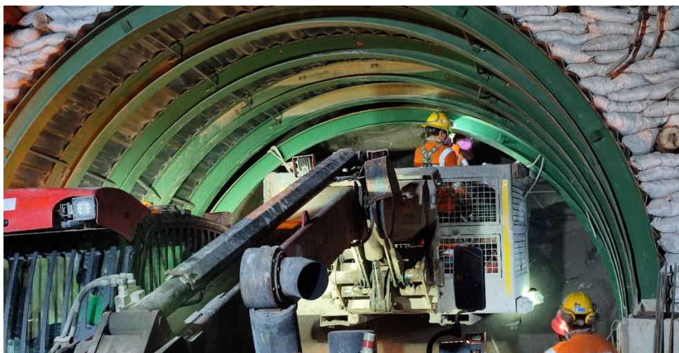
Anexo 16: Proceso de colocado del arco de la cimbra.
