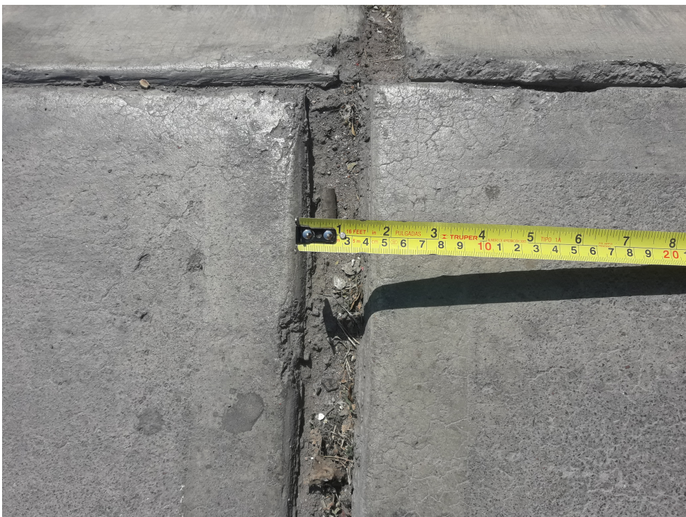
Figura 86 Medición de juntas - Jr. Los Rosales
