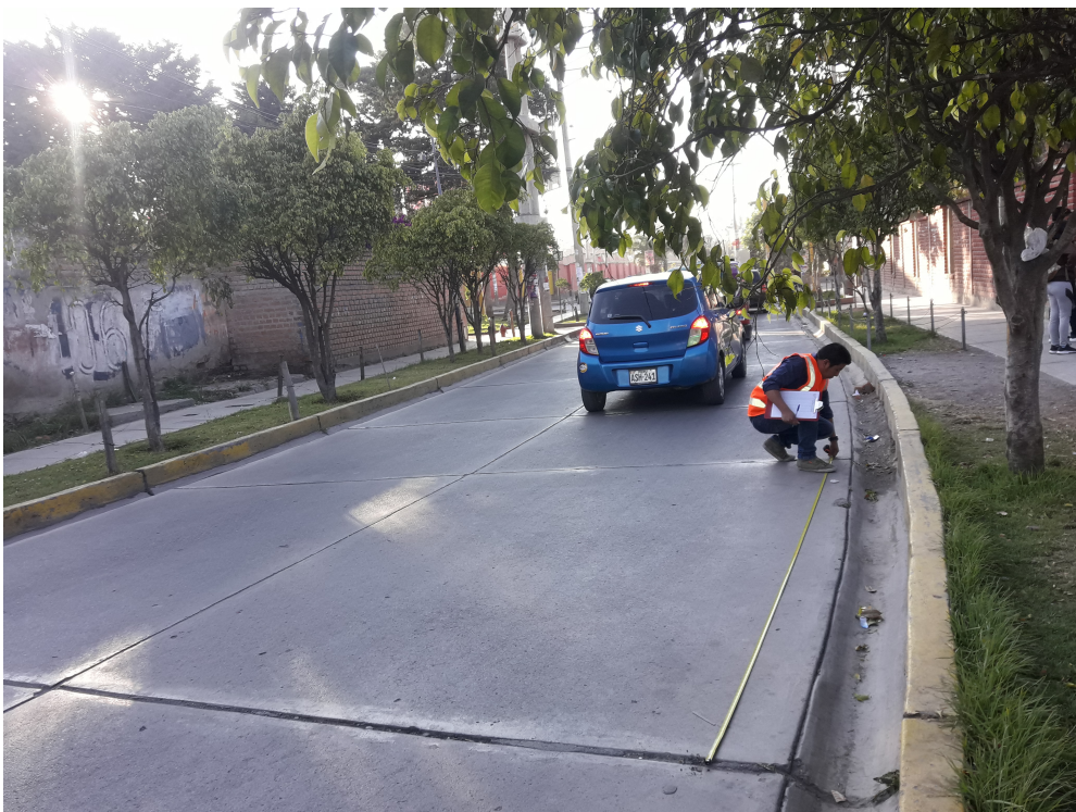
Figura 84 Medición de losa - Av. 26 de Enero
