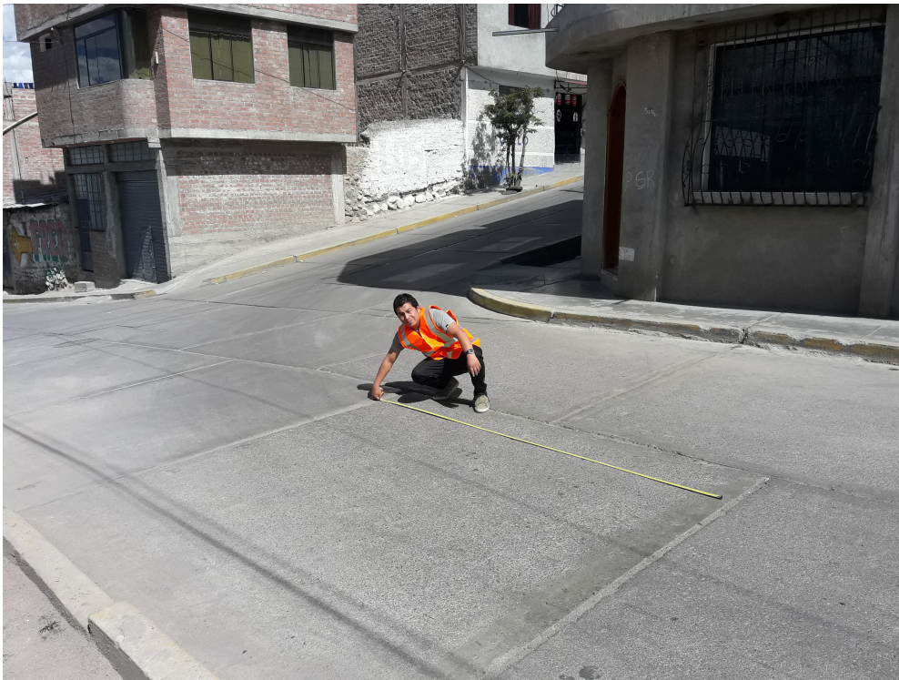
Figura 85 Medición de losa - Jr. Los Rosales
