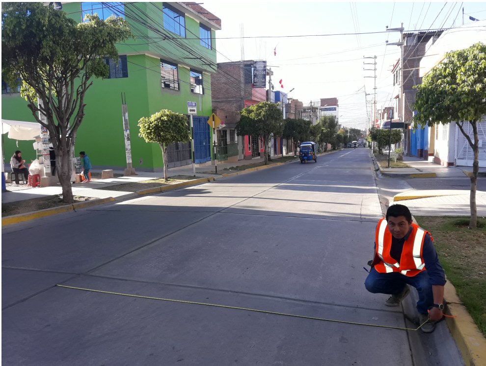
Figura 83 Medición de losa - Av. 26 de Enero
