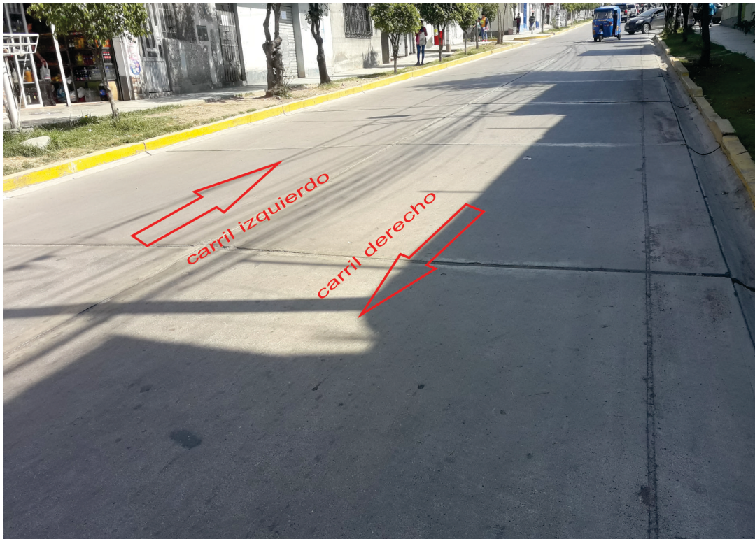
Figura 35 Pavimento actual del Av. 26 de enero Fuente: Obtenido de Elaboración propia .
