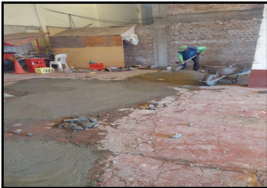
Fotografía 14. "Subempleados " trabajando en construcción como peón.
