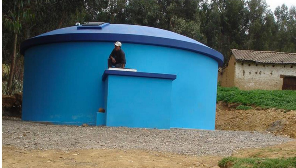
Figura N° 1.10: Almacenamiento de agua potable
