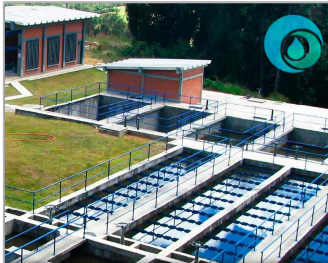
Figura N° 1.9: Planta de tratamiento de agua potable
