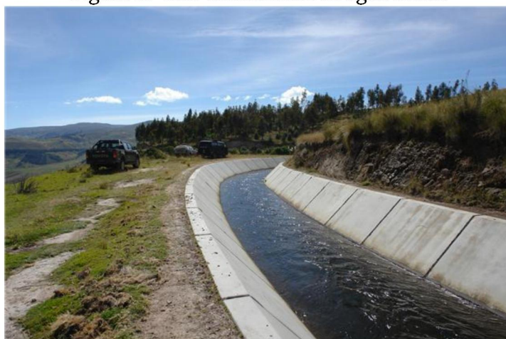
Figura N° 1.8: Conducción de agua cruda
