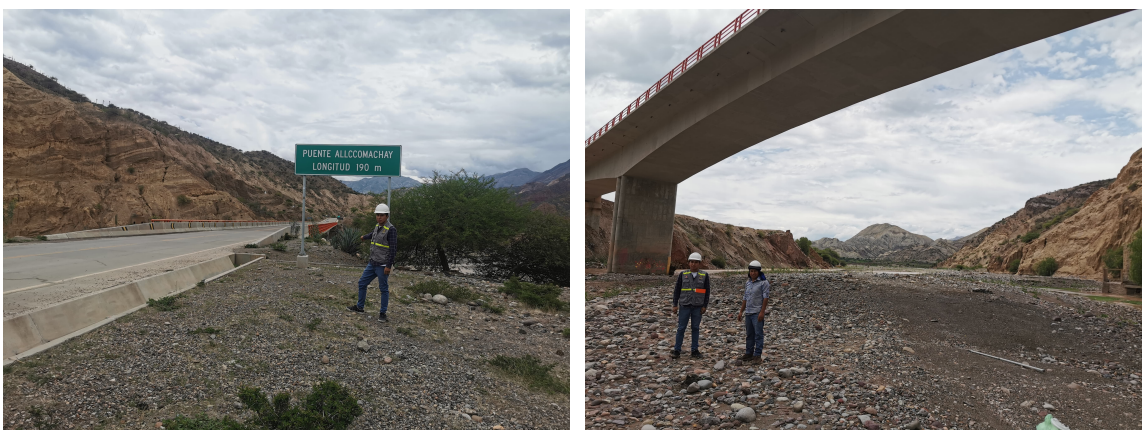
Figura 8: Río Cachi con intersección al puente Allccomachay
