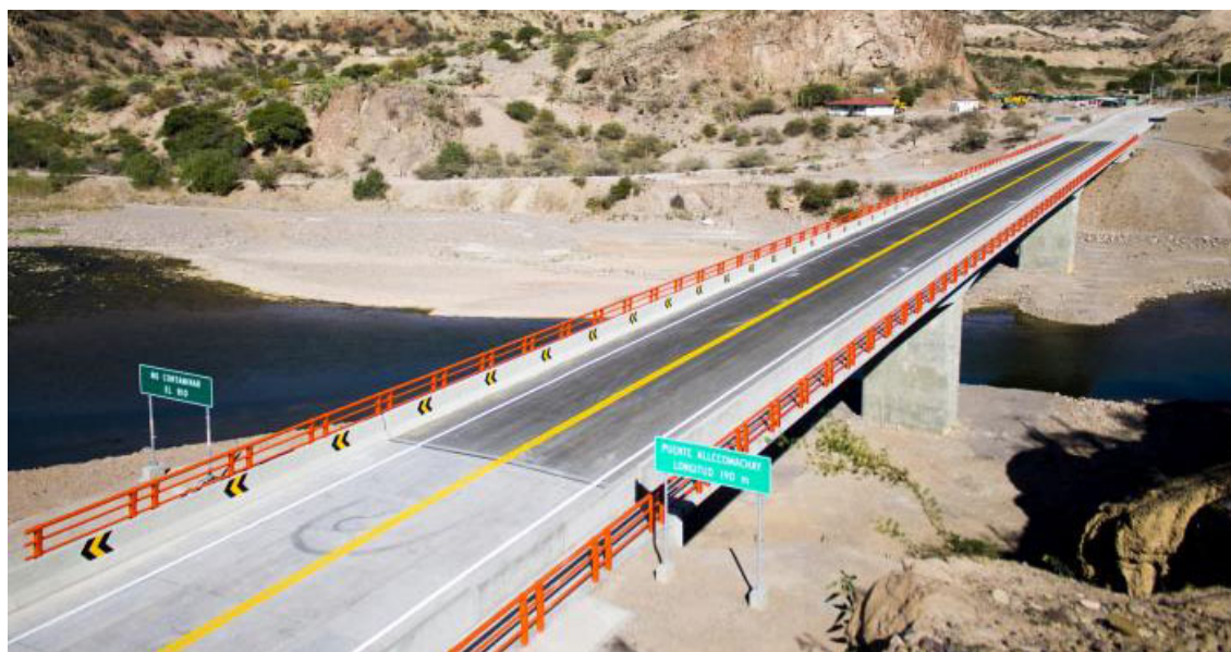
Figura 11: Vista panorámica del puente Allcomachay.
