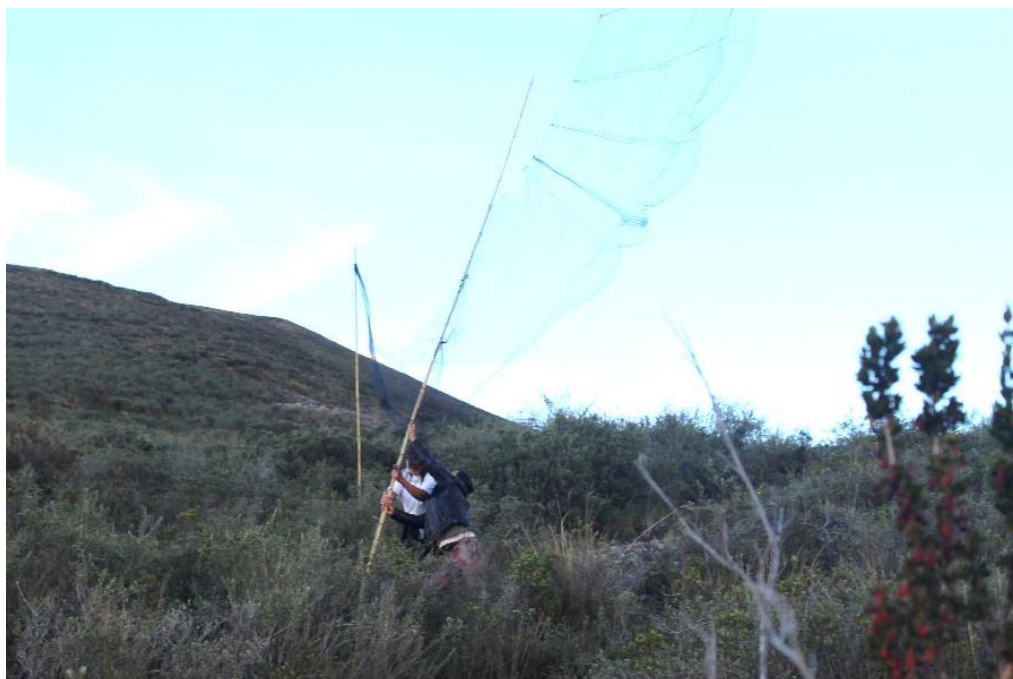
Anexo 4. Instalación de la red de niebla.
