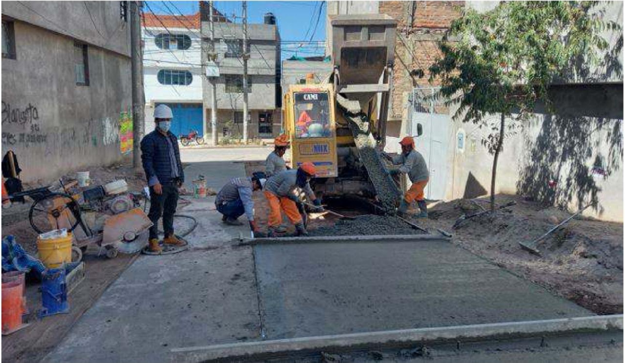
Figura B.3 Vaciado de concreto de pavimento en la Primera cuadra del Jr. Pikimachay. Fuente: Elaboración propia
