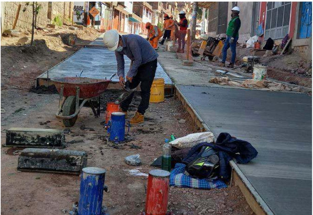
Figura B.8 Obtención de testigos de concreto adicionado con fibras de acero en 7.5 % respecto al peso de cemento.
