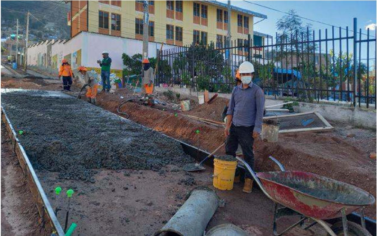
Figura B.9 Preparado del concreto adicionando fibras de acero en 10 % respecto al peso del cemento.
