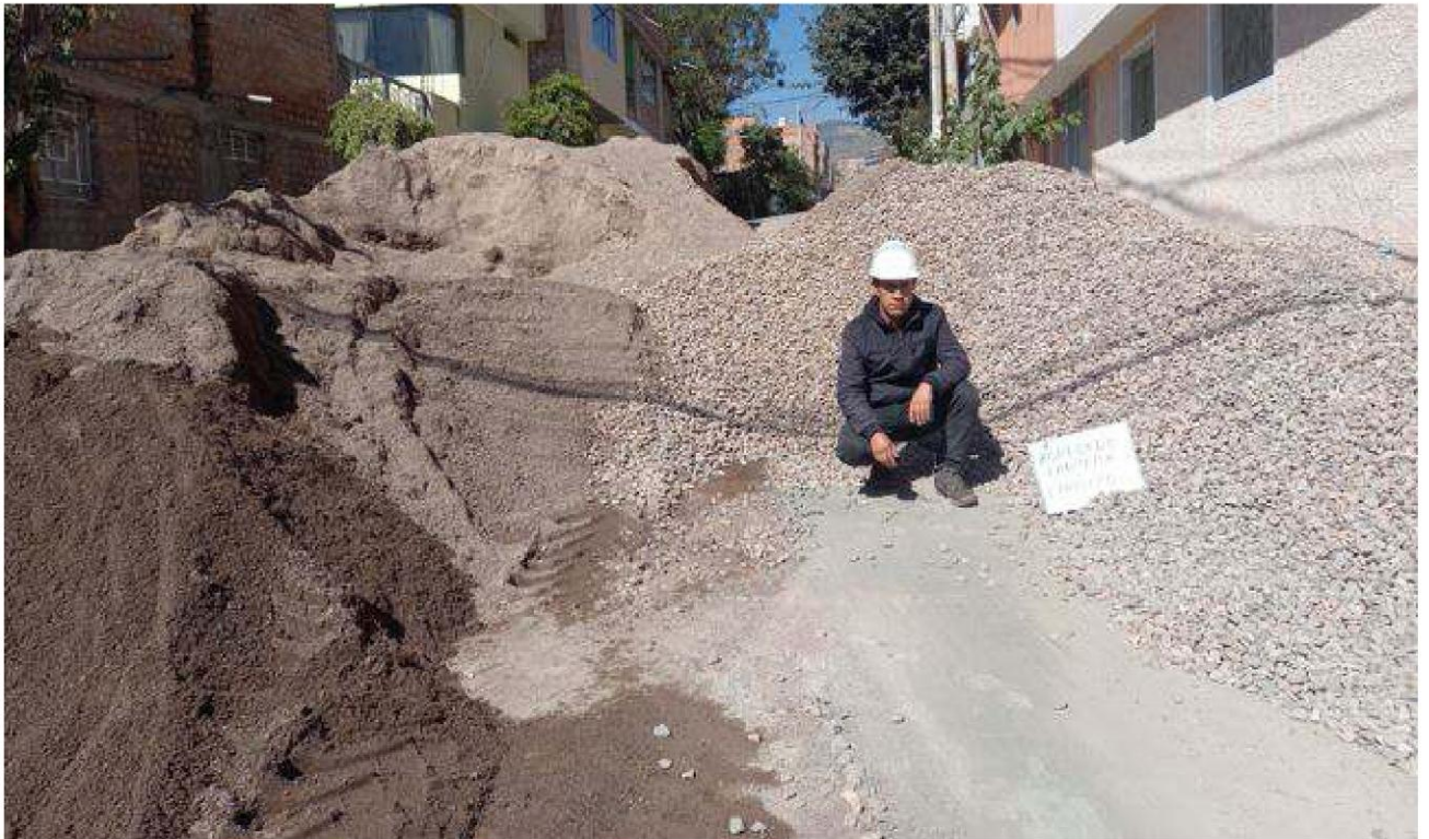
Figura B.1 Agregados de la Cantera Chillico puesto en Obra.
