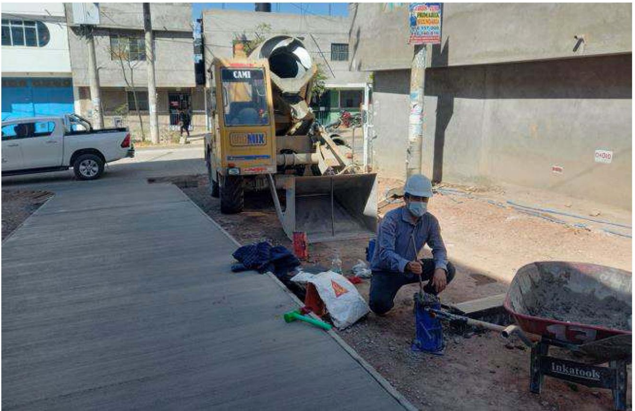
Figura B.6 Obtención de testigos de concreto adicionado con fibras de acero en 5 % respecto al peso de cemento. Fuente: Elaboración propia
