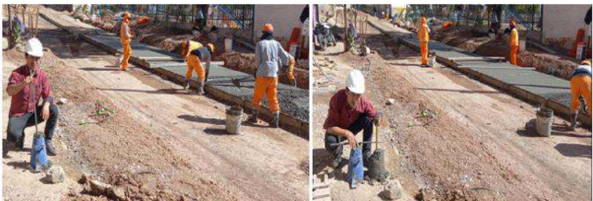
Figura B.2 Llenado de concreto en el cono de Abrams, y medición del asentamiento (slump).
