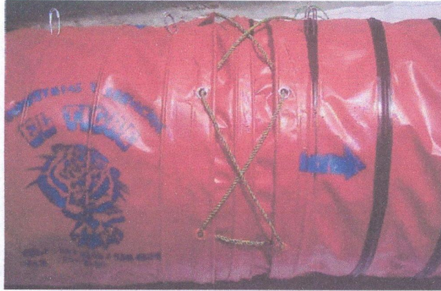
Fotografía 2.4: Acople y suspensión radial en los extremos del ducto.
