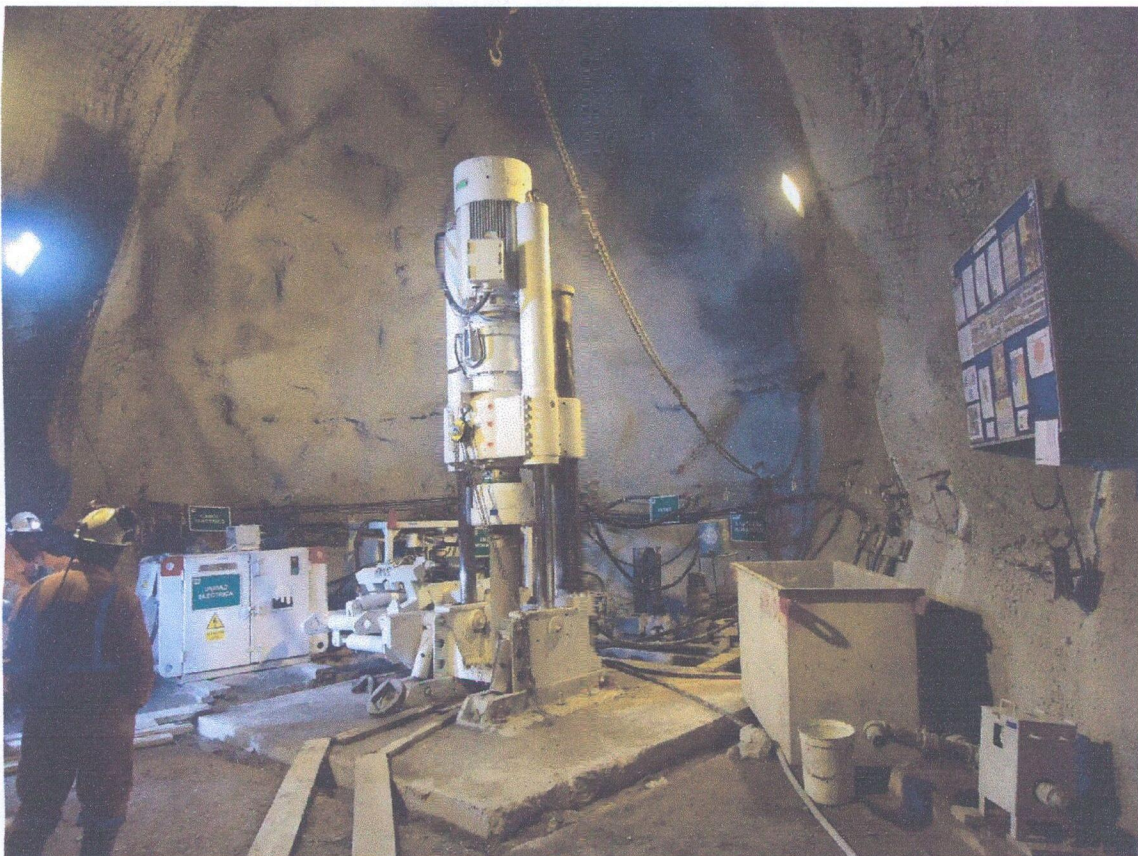
Fotografía 06: Raise Boring en operación de RB-10A
