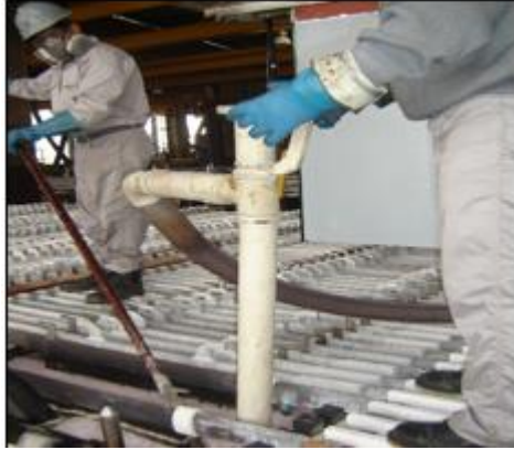
Figura 4.3: Limpieza de celdas Fuente: Propia
