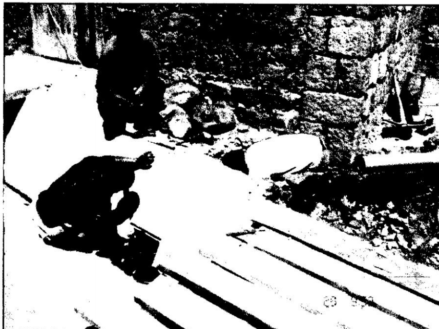
Trabajos de Construcción de la caseta limnigráfica “killa”
