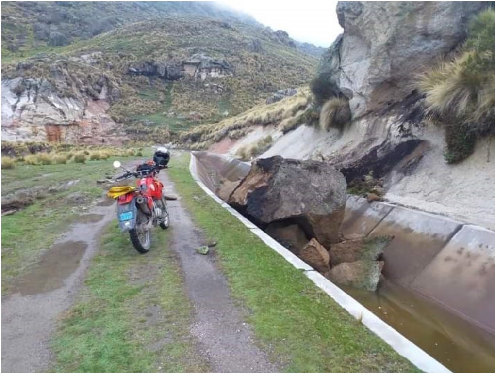
Figura 8 Obstrucciones en el canal
