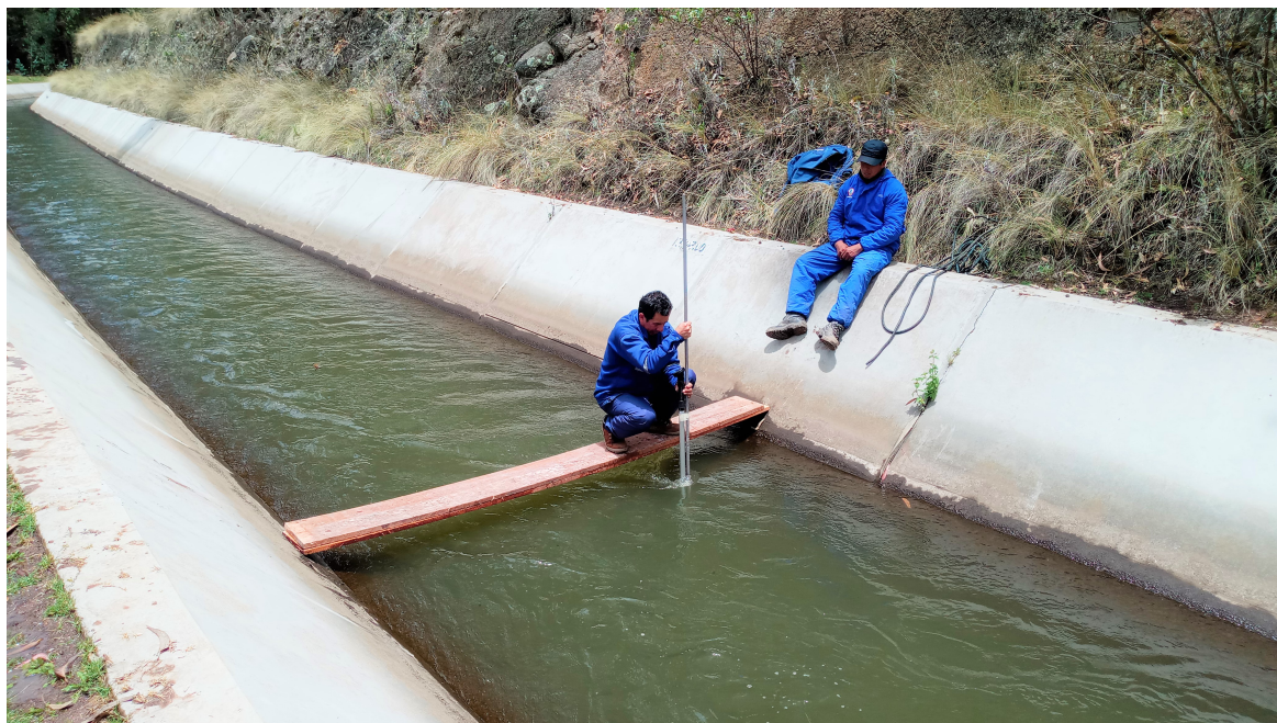
Figura 26 Medición de la velocidad en un punto de la sección del canal
