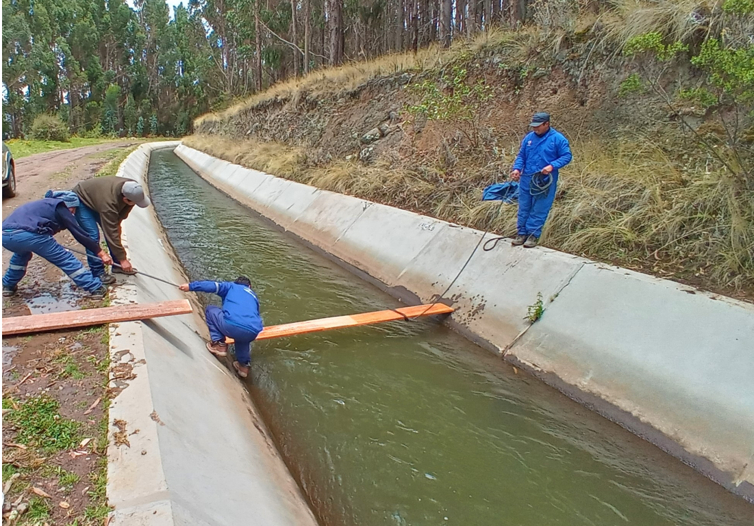
Figura 23 Instalación de tablas para hacer uso del correntómetro global water digital Fuente: Elaboración propia
