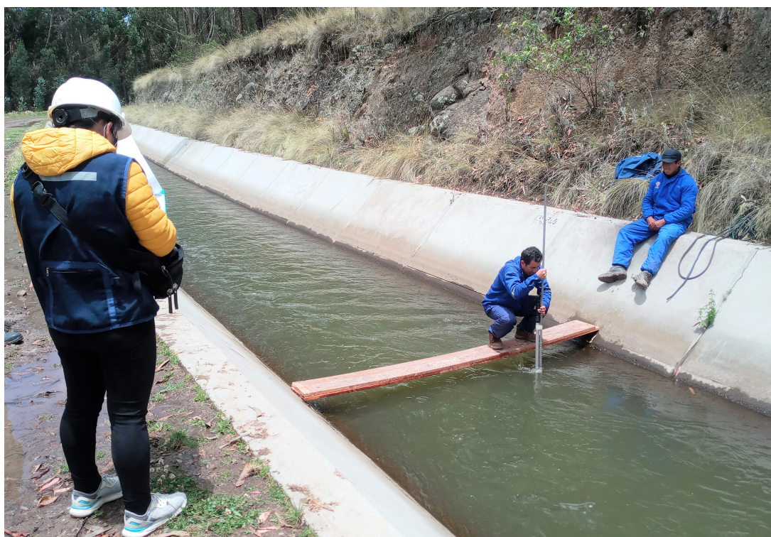
Figura 25 Medición del tirante de la sección del canal
