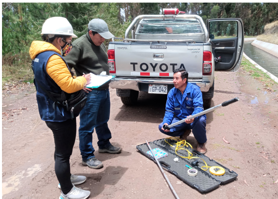
Figura 15 Instalación del Correntometro Global Water digital Fuente: Elaboración propia
