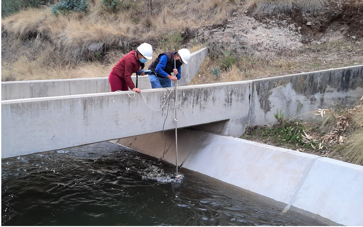
Figura 19 Verificando si el lugar es adecuado para realizar el aforo.
