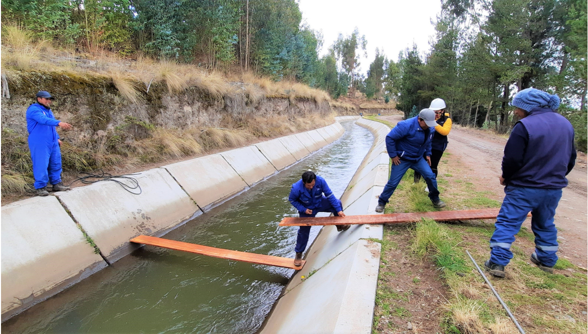
Figura 29 Instalación de tablas para hacer uso del correntómetro global water digital Fuente: Elaboración propia
