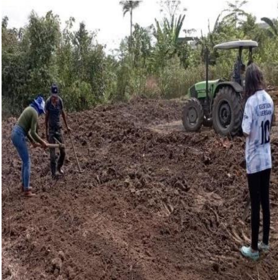
FOTO 7: Nivelación del terreno. FECHA: 13/07/2023
