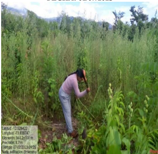
FOTO 3: Limpieza del terreno FECHA: 02/07/2023
