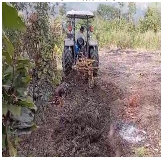
FOTO 6: Roturación de suelo.
