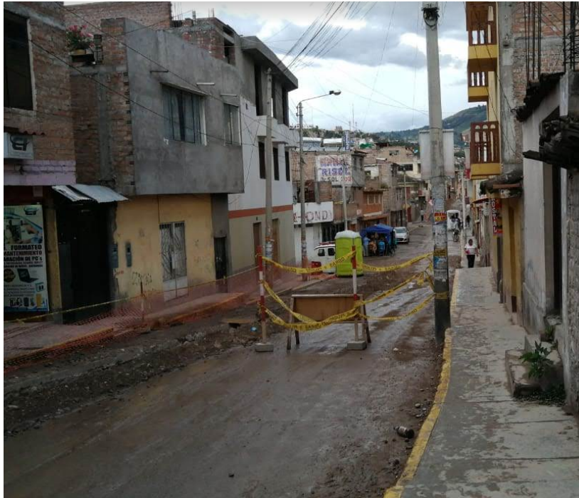
Figura 4.16: Cierre del Jr. Sol por trabajos de mantenimiento
