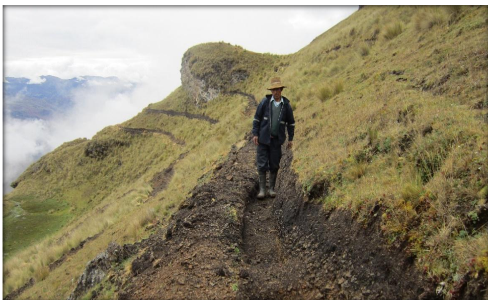
Figura 3.28. Construcción de zanjas de infiltración – Paqchaq Anco
