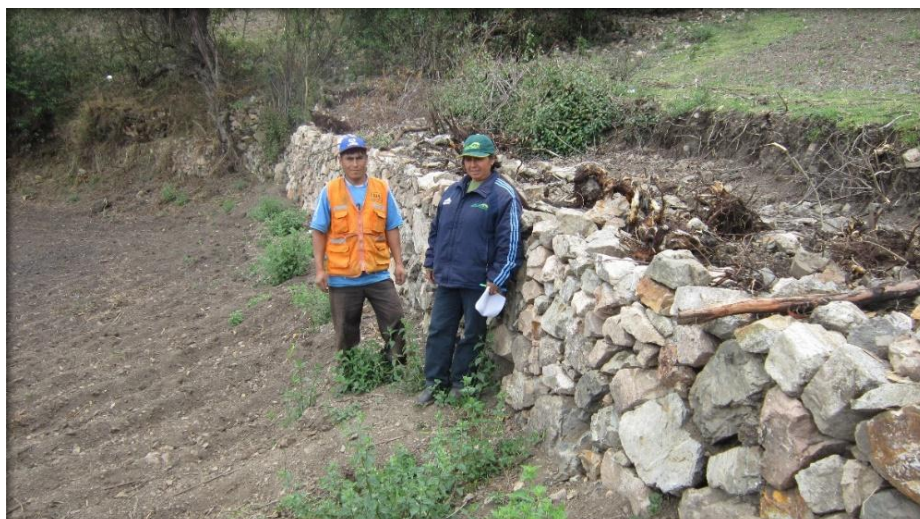
Figura 3.1. Terraza de absorción de piedra. Aquilla – San Miguel
