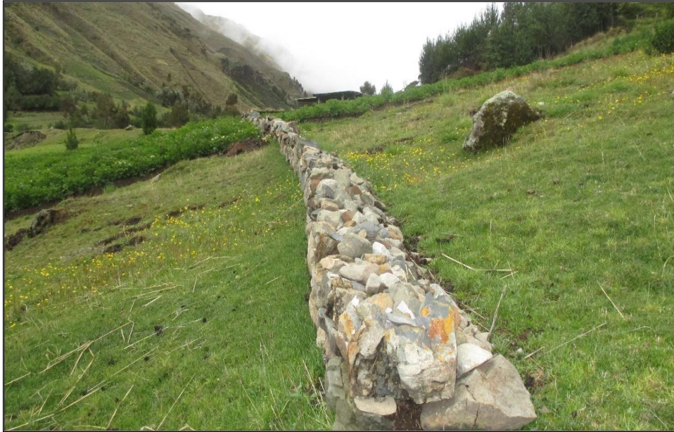
Figura 3.30. Terrazas de formación lenta – Qanchiqocha Anco
