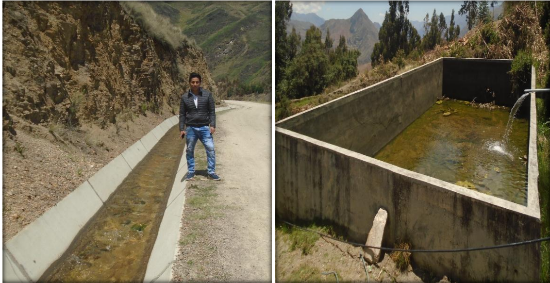
Figura 3.24. Canal y reservorio del proyecto de irrigación Masinga Tambo La Mar
