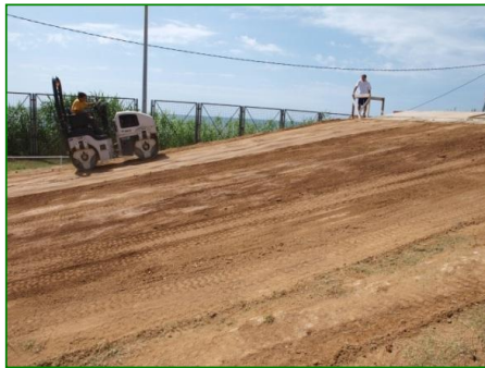
3. Mezclar la solución con el terreno, compactar y dejar secar
