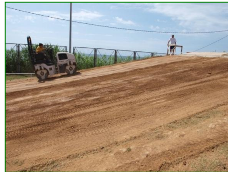
3. Mezclar la solución con el terreno, compactar y dejar secar
