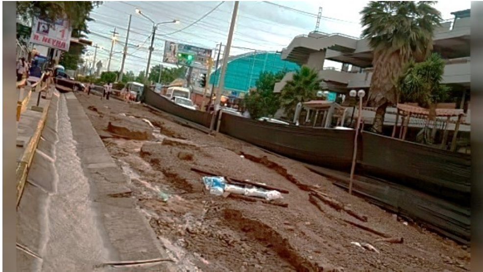
Figura 5: Paralización de trabajos en la obra de pavimentación urbana de la Av. Independencia.
