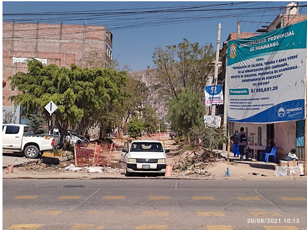
Figura 6: Paralización de trabajos en la obra de pavimentación urbana de la Av. Masprone.
