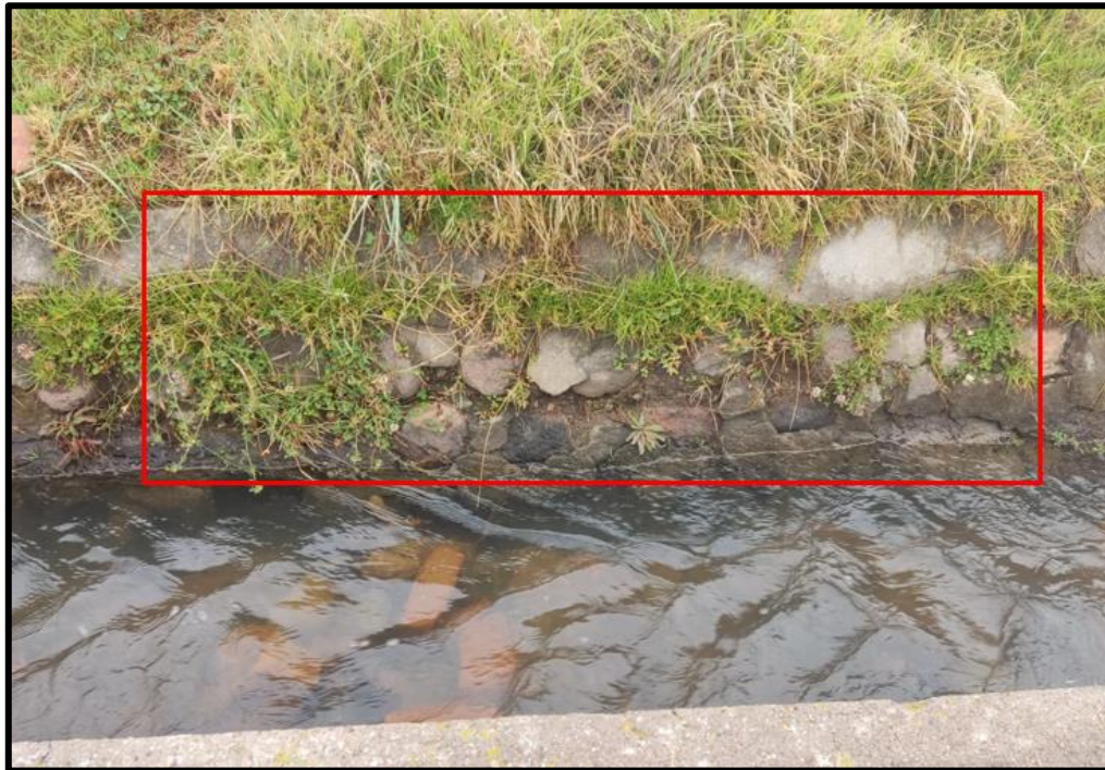
Figura N°4: Erosión lateral
