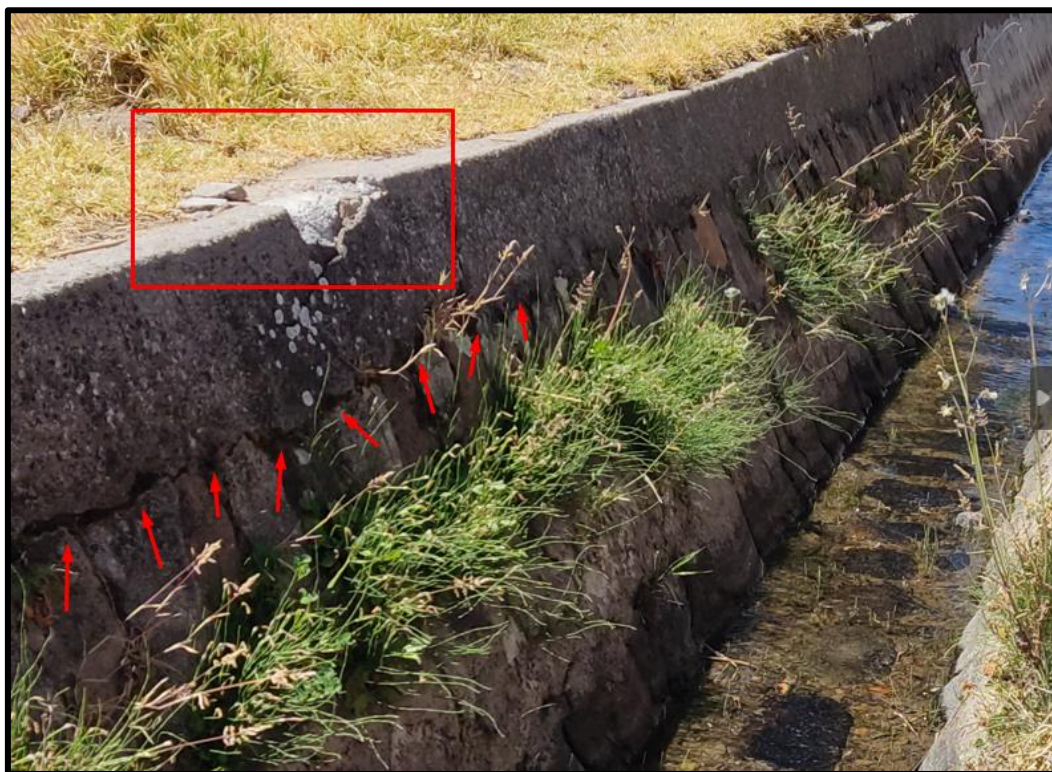
Figura N°5: Fracturamiento lateral
