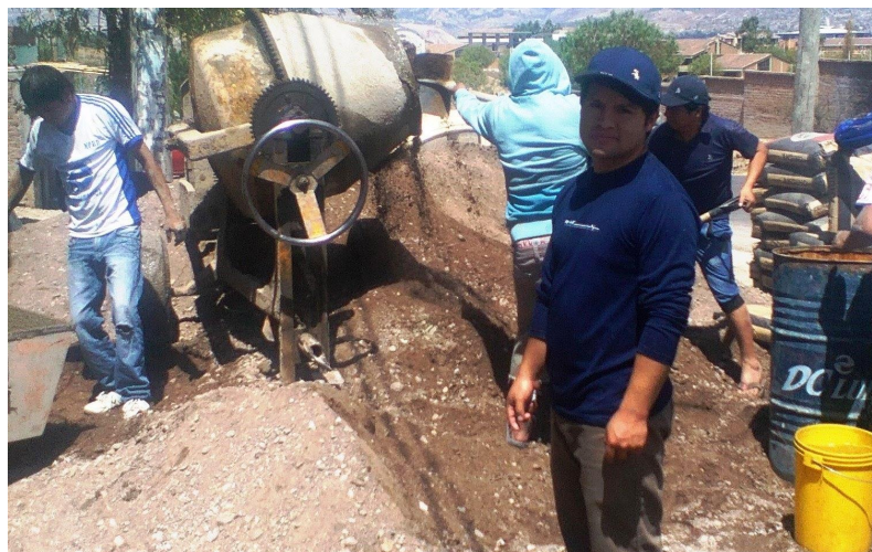
Figura C.2: Fotografía donde se aprecia la utilización del hormigón para el vaciado de la losa.
