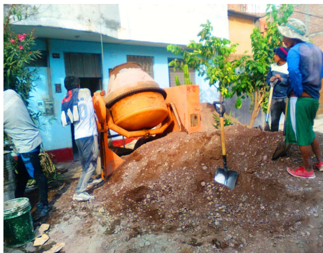
Figura 2.11: Vaciado de losa con concreto artesanal en el distrito de Jesús Nazareno. Octubre - 2016.
