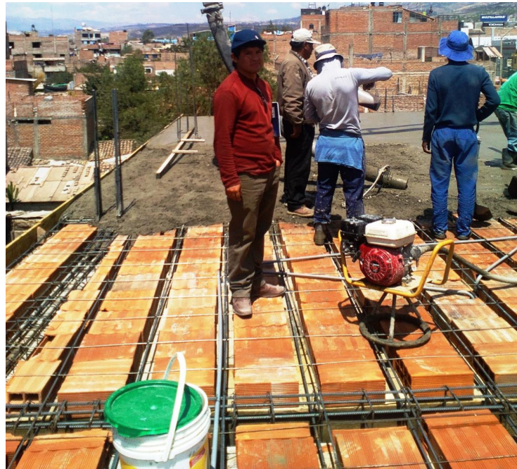
Figura C.3: Se observa la obtención de muestras en el concreto pre-mezclado.
