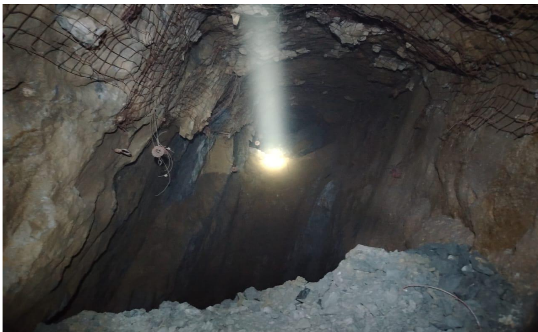
Foto 5: Relleno de tajo explotado con desmonte (material detrítico) para mantener estabilidad de macizo rocoso.
