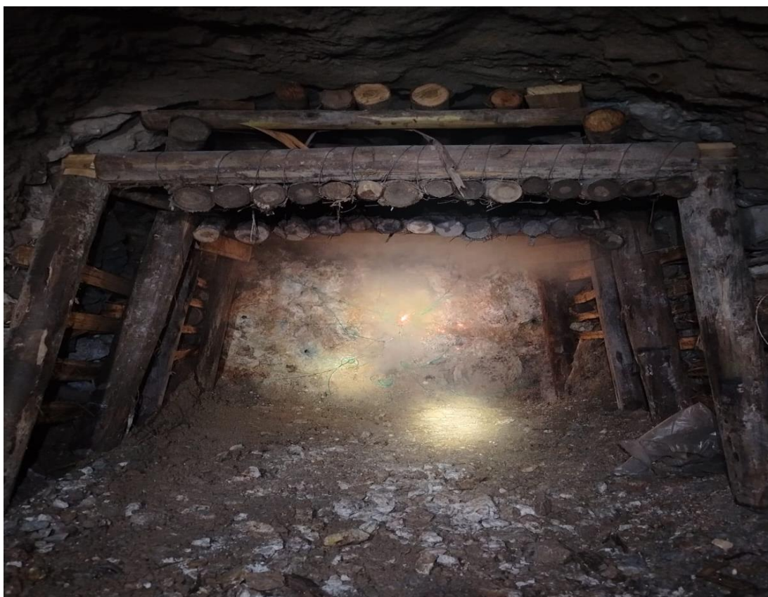
Foto 11: Armado de cuadro sobre estructura mineralizada
