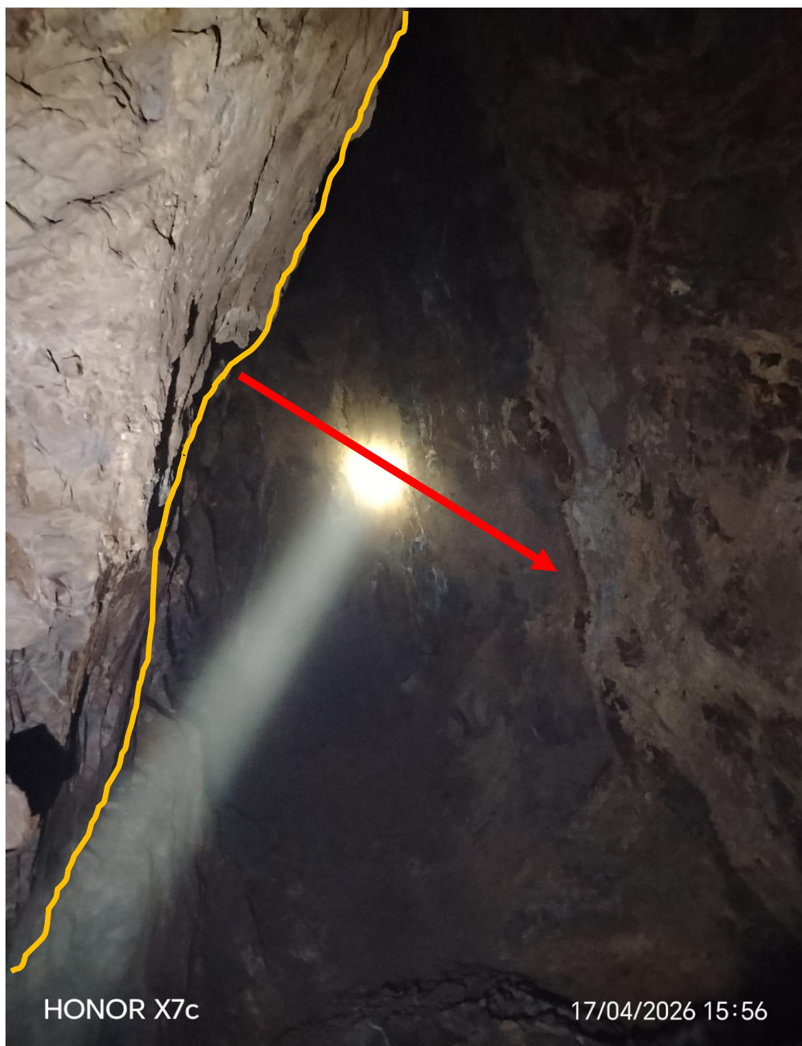
Foto 16: Resultado de la perforación y voladura controlada después de armado de cuadro sobre estructura.
