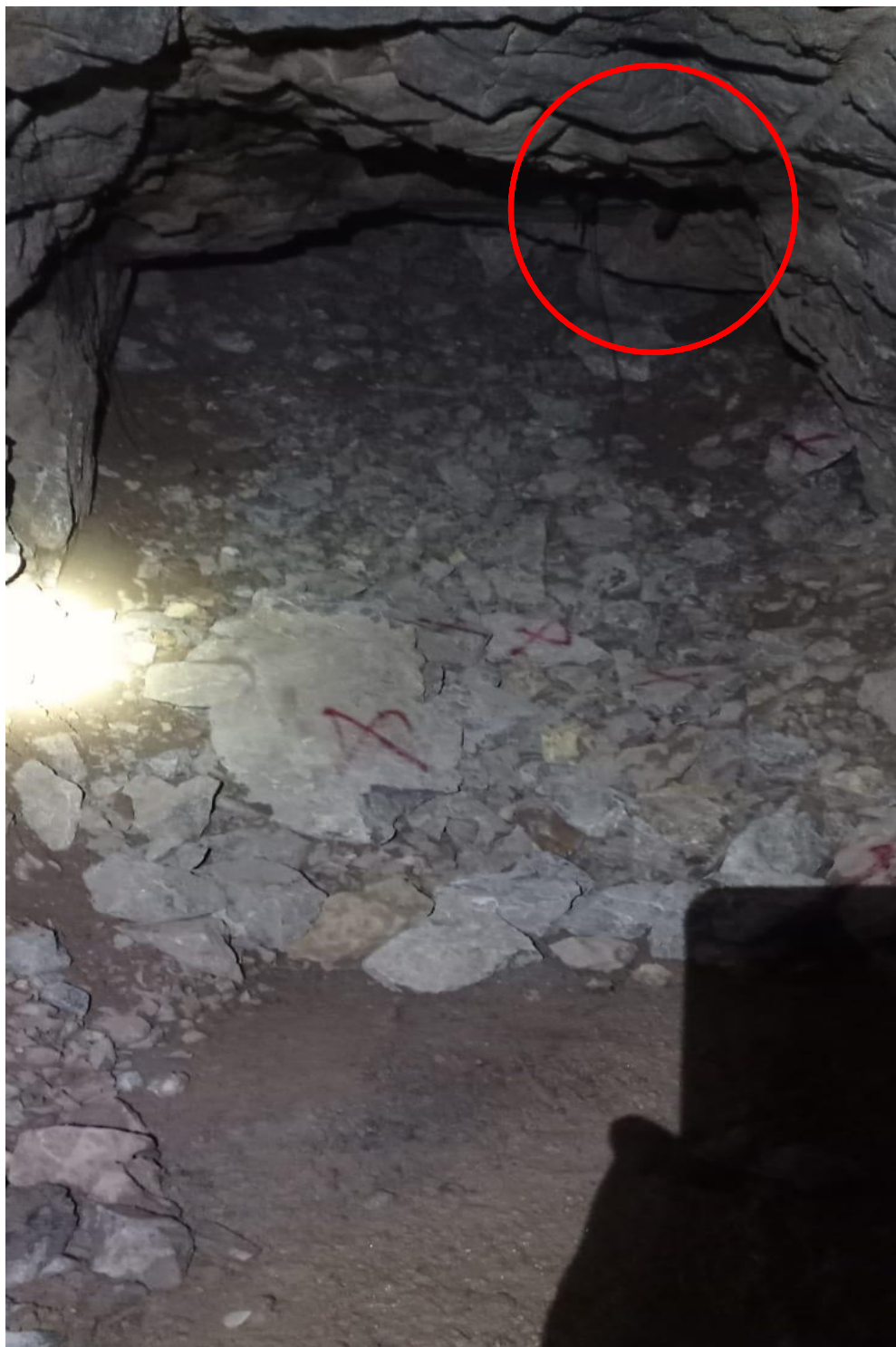
Foto 6: Perforación de la estructura mineralizada sin control, perjudicando caja piso y techo y generando desestabilidad.
