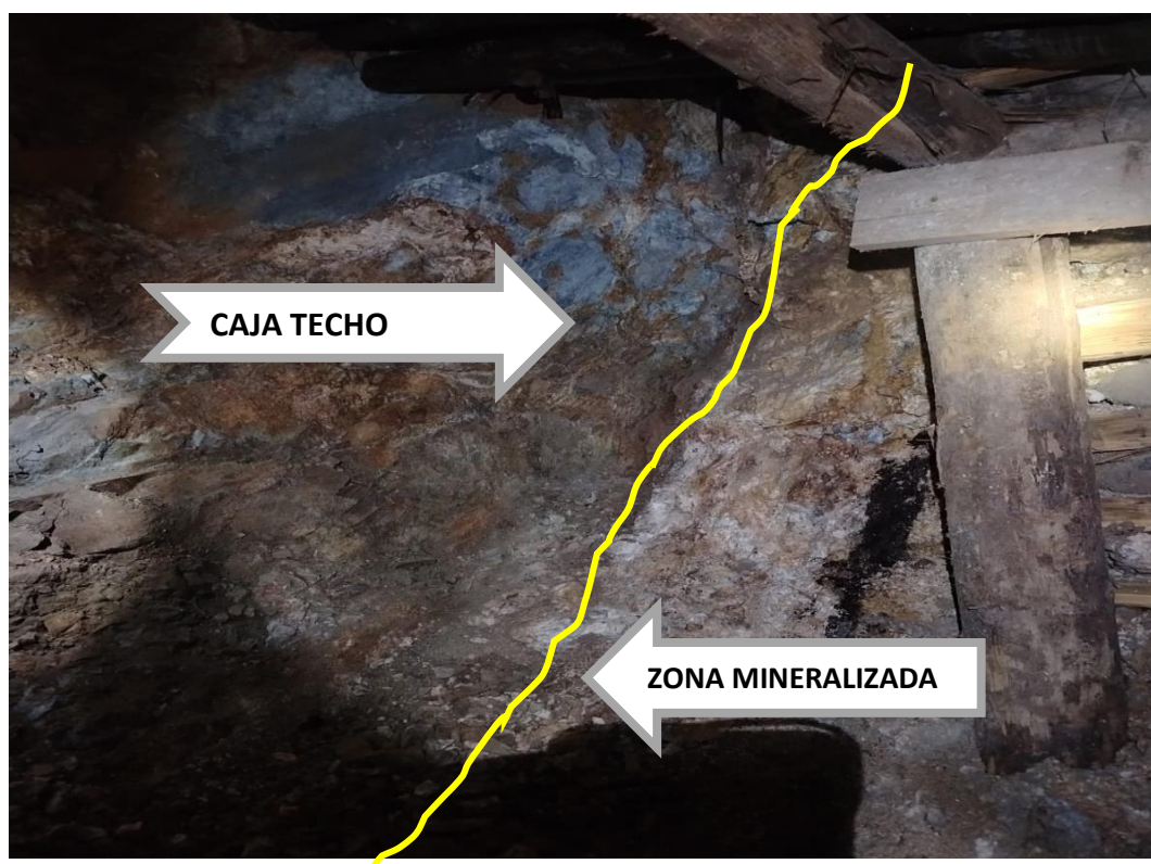
Foto 13: Armado de cuadro hasta el límite entre caja encajonante (caja techo) y estructura mineralizada
