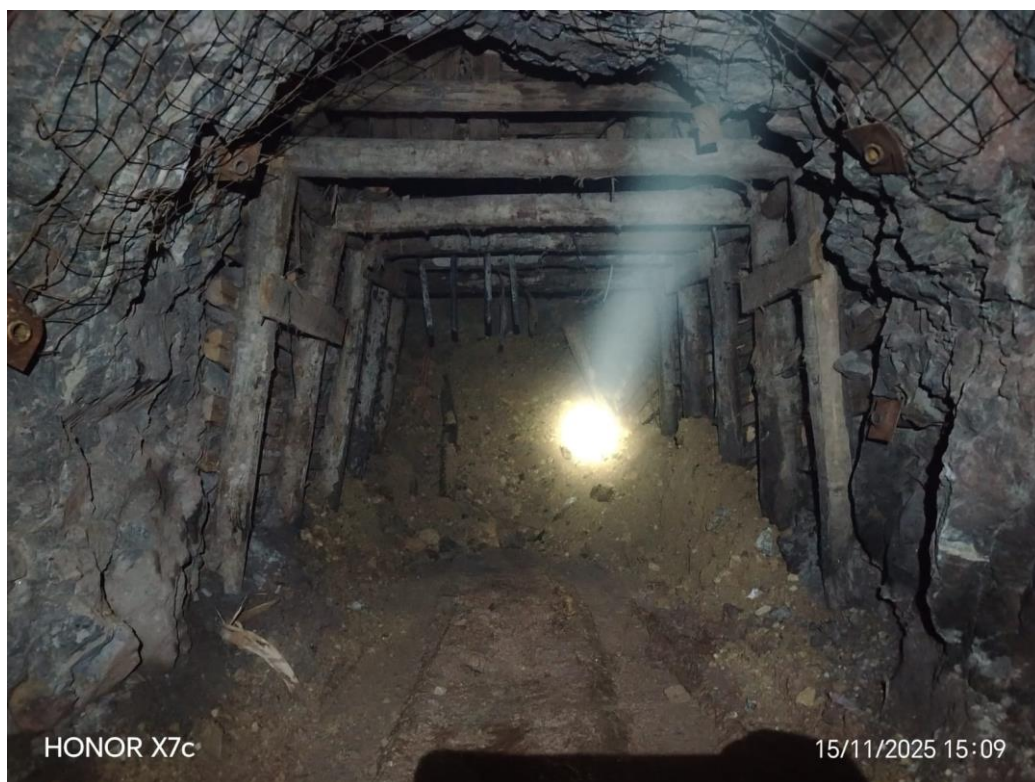
Foto 15: Resultado de la perforación y voladura de taladros largos.
