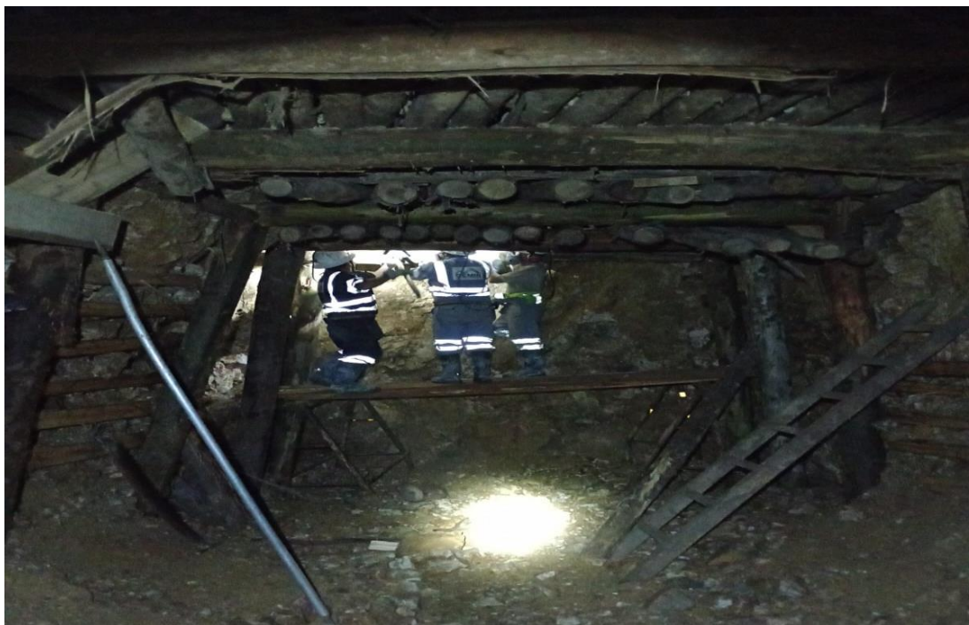
Foto 10: Proceso de armado de cuadro sobre estructura mineralizada.
