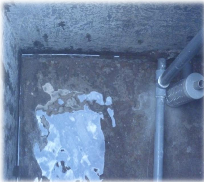
Hipoclorador en el reservorio de Huayllahura
