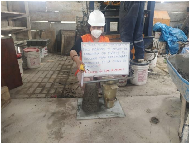
a) Medición del Slump con el Cono de Abrams
