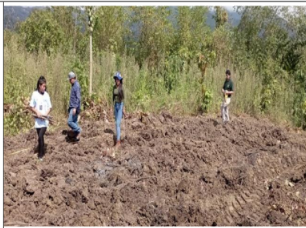
FOTOGRAFÍA 08: Trazo del terreno.
