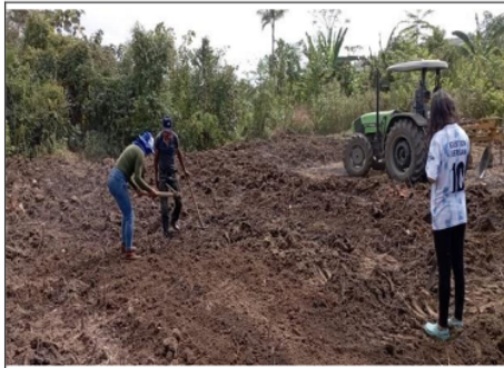
FOTOGRAFÍA 07: Nivelación del terreno.
