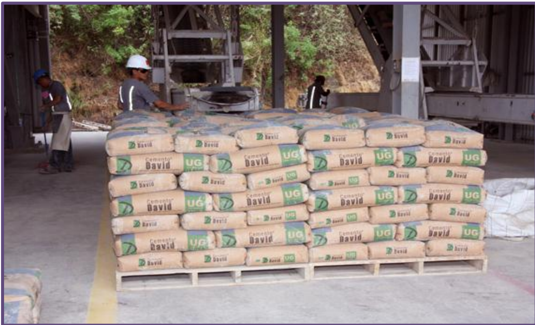
Figura 1.3 Almacenamiento del cemento
