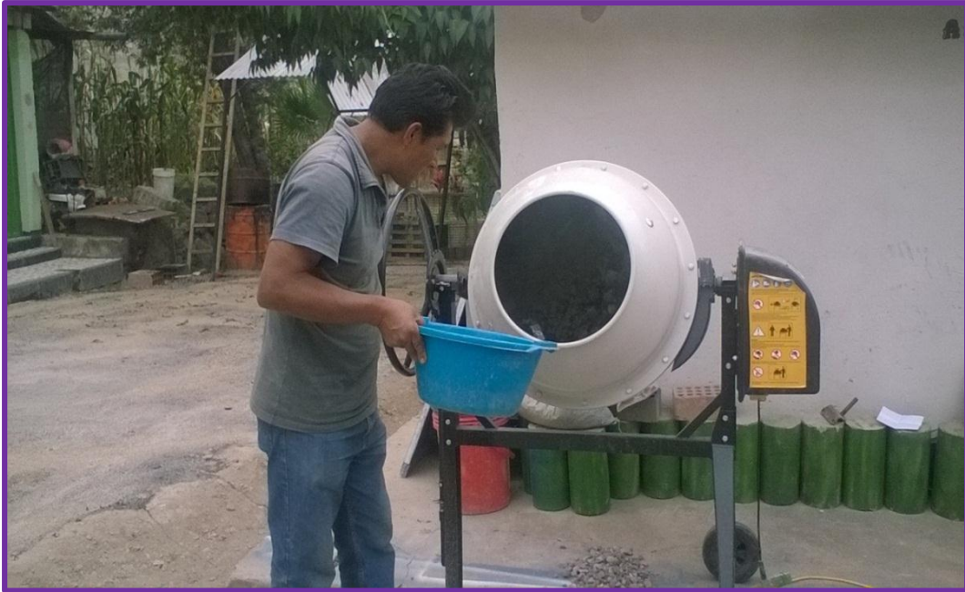
Figura 3.36 Agregando la cantidad de agua correcta de acuerdo a la dosificación
