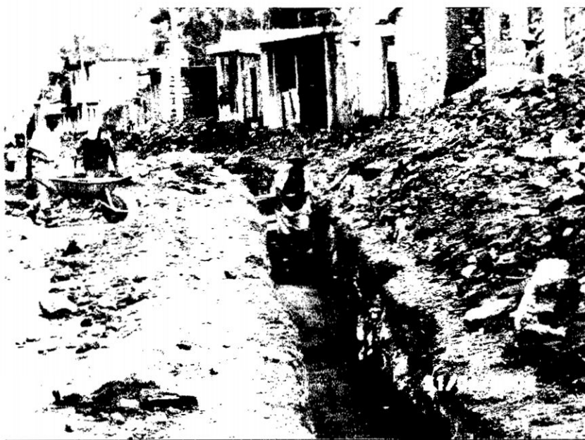
Figura G.4: Compactación manual de la red de tubería
