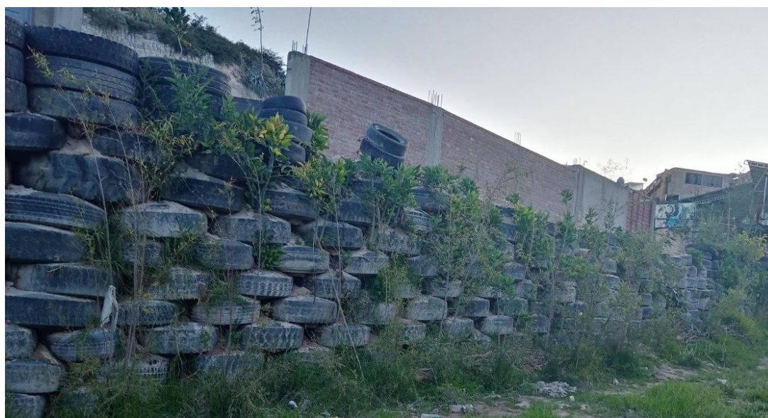
Figura I.2: Muro de contencion existente en Totorilla
