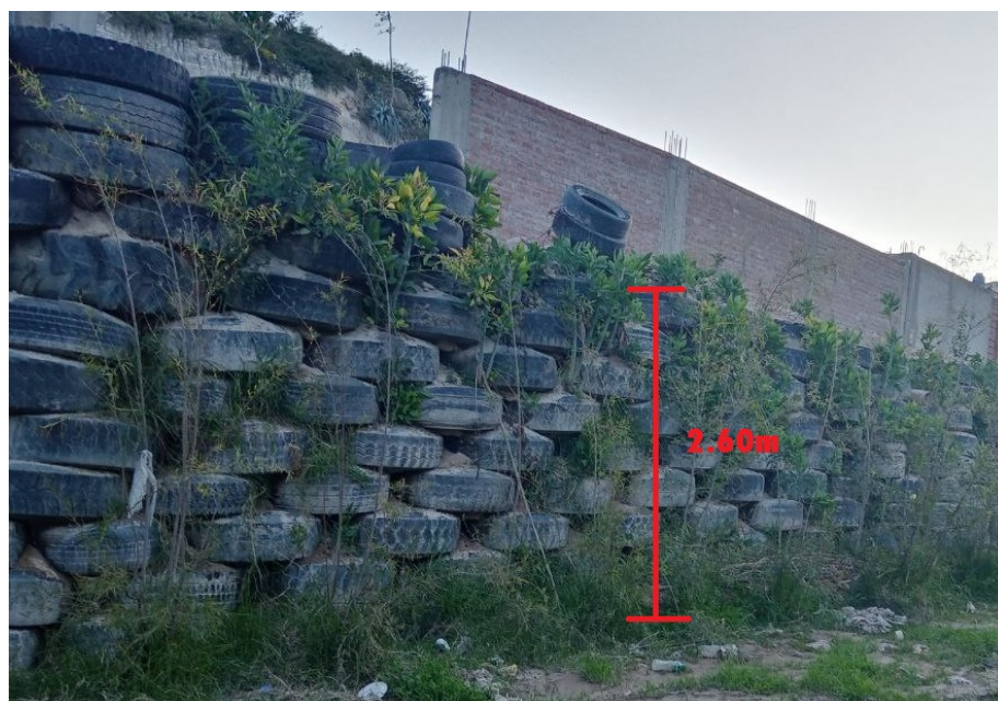
Figura III.18: Muro de contención existente en la zona de estudio
