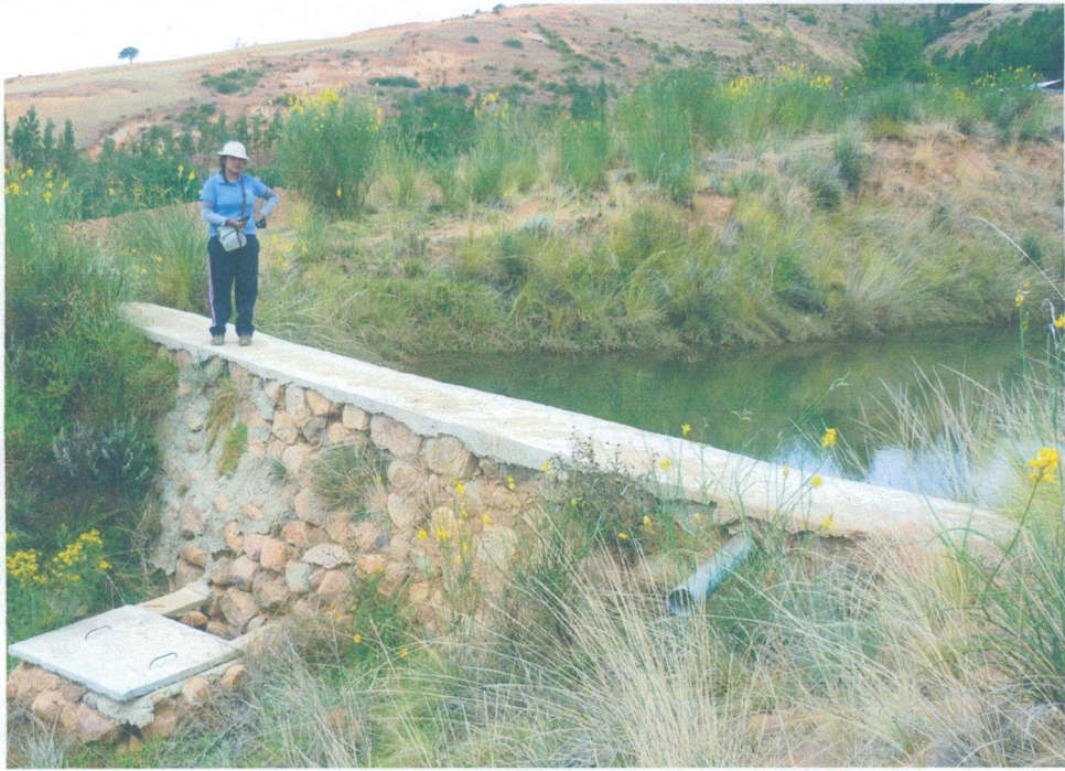
Fotografía N°01: Reservorio – Cámara de carga del sistema de riego en la comunidad de Llutacancha.
