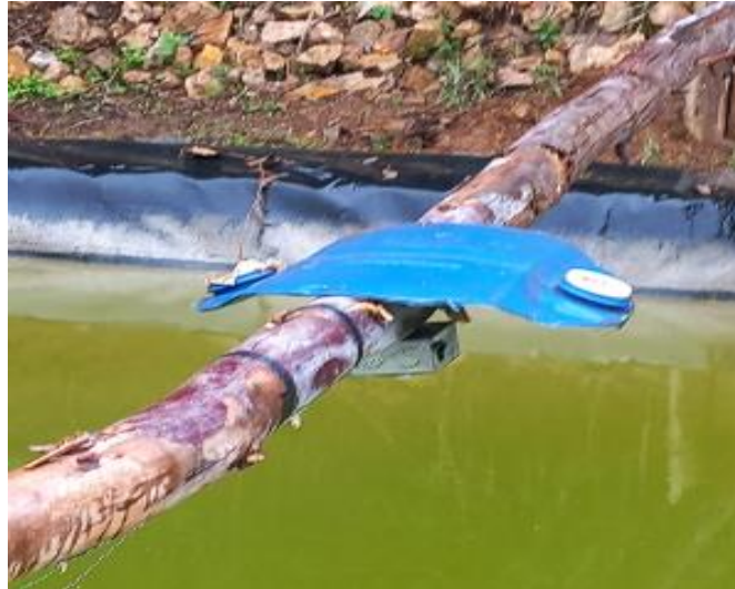
Figura 2. 30 Instalación del sensor ultrasónico HC-SR04
