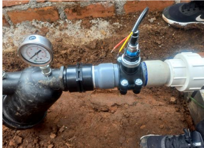
Figura 2. 32 Instalación del sensor de presión Hk3025
