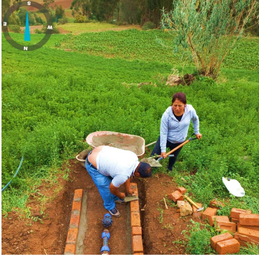
Figura 3 Construcción de la caja de protección del cabezal de riego
