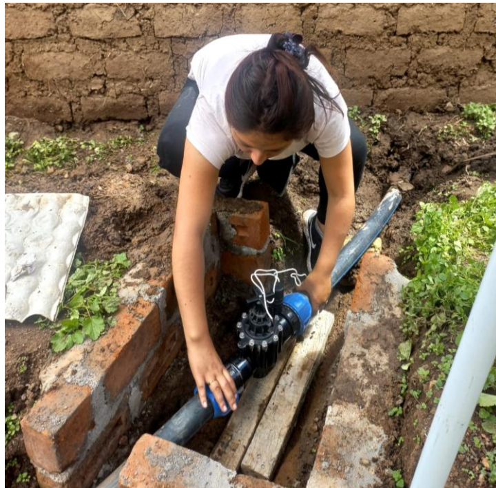
Figura 2. 48 Instalación de la electroválvula
