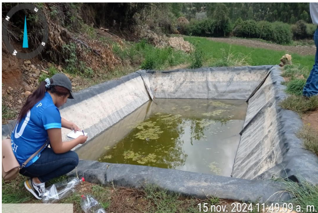
Figura 2. 5 Reservorio de agua revestido con geomembrana
