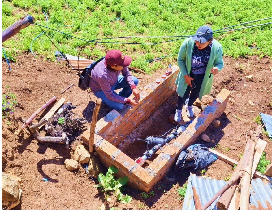
Figura 11 Inspección de mi asesor sobre la instalación de los sensores
