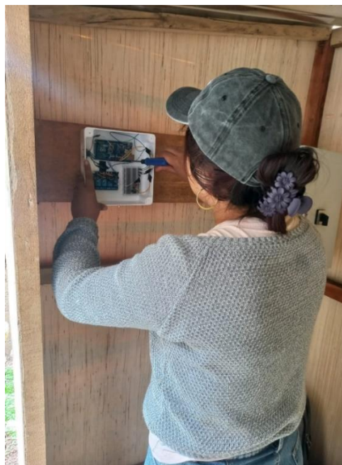
Figura 2. 43 Instalación de la placa Arduino Mega 2560 R3
