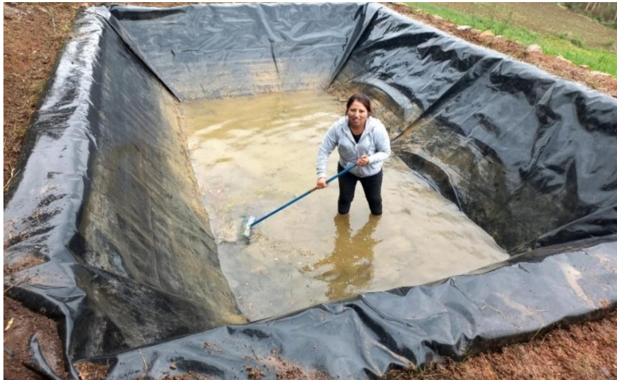
Figura 2. 25 Limpieza del reservorio
