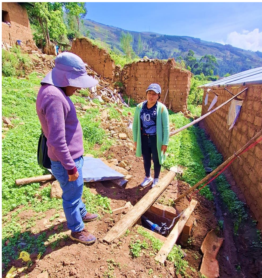
Figura 12 Inspección de mi asesor sobre la instalación de la electroválvula
