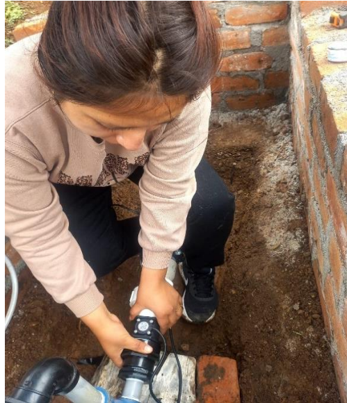
Figura 2. 34 Instalación del sensor de flujo YF-DN50
