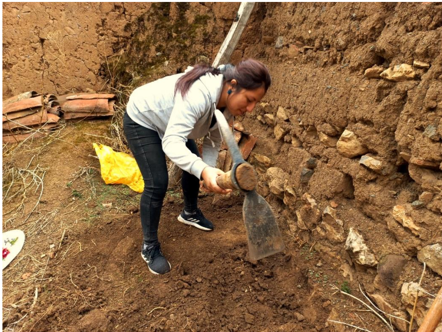
Figura 4 Limpieza para la instalación de la caseta de control
