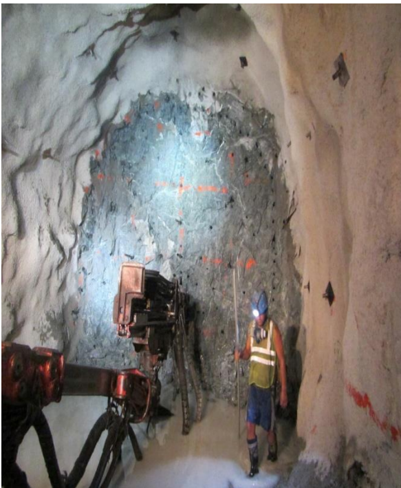
PROCESO DE PERFORACION JUMBO
