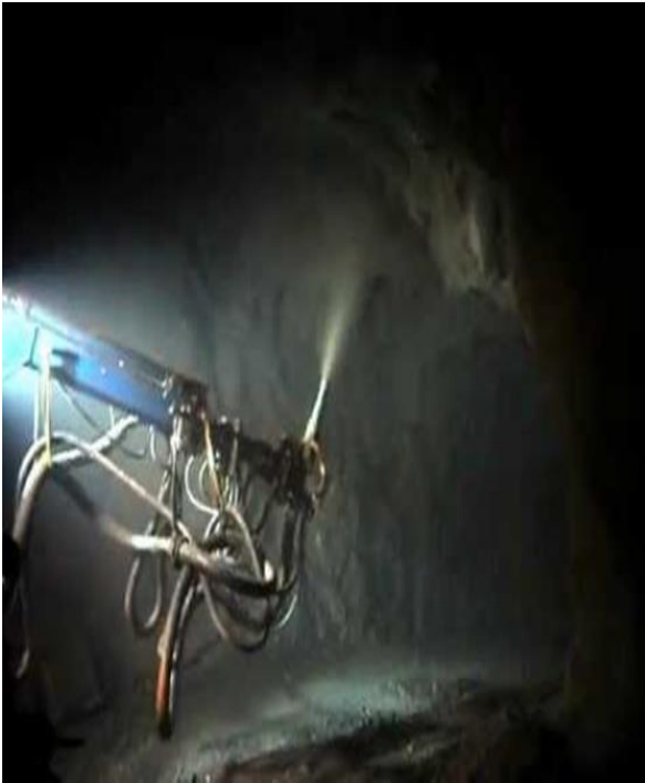
LANZADO DE SHOTCRETE ROBOT
