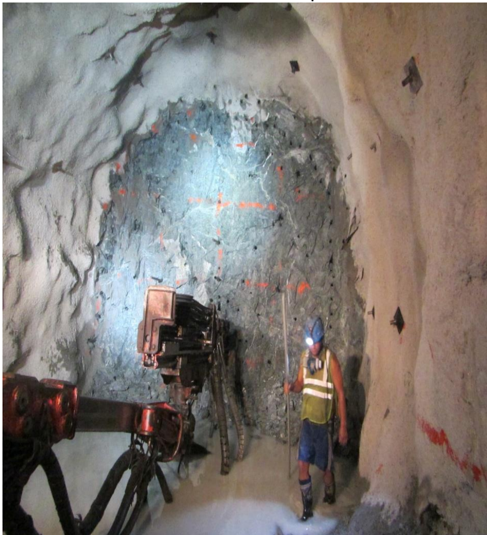
FOTO N° 04 Proceso de perforación
