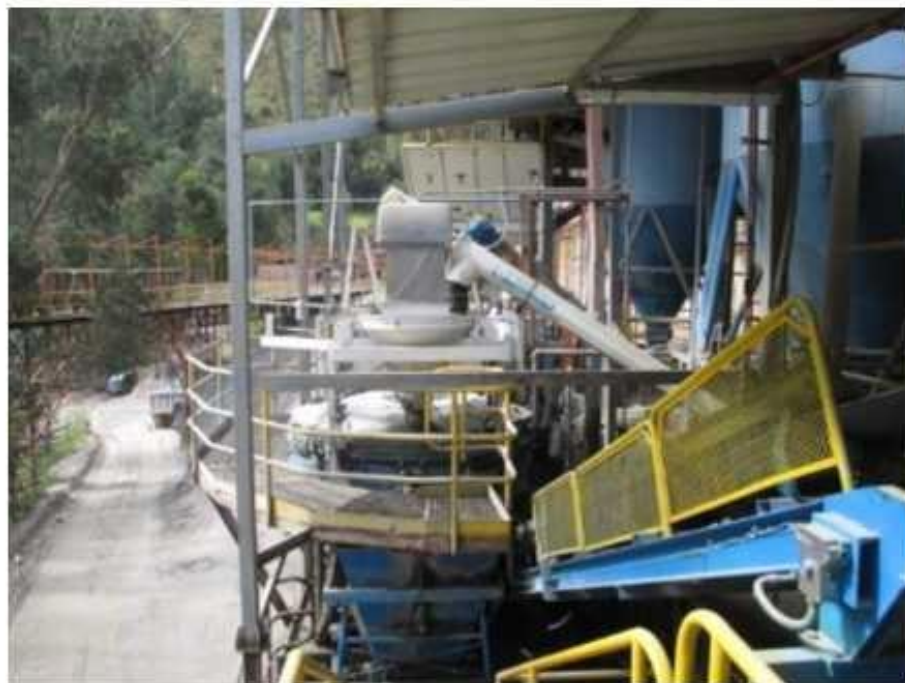
FOTO 2. PLANTA DE SHOTCRETE II BALCÓN
