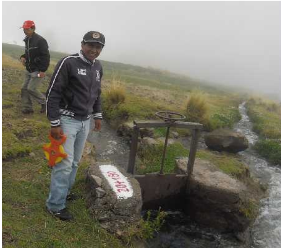
FOTO N° 07: Evaluación de la infraestructura hidráulica existente - Campanayocc.
