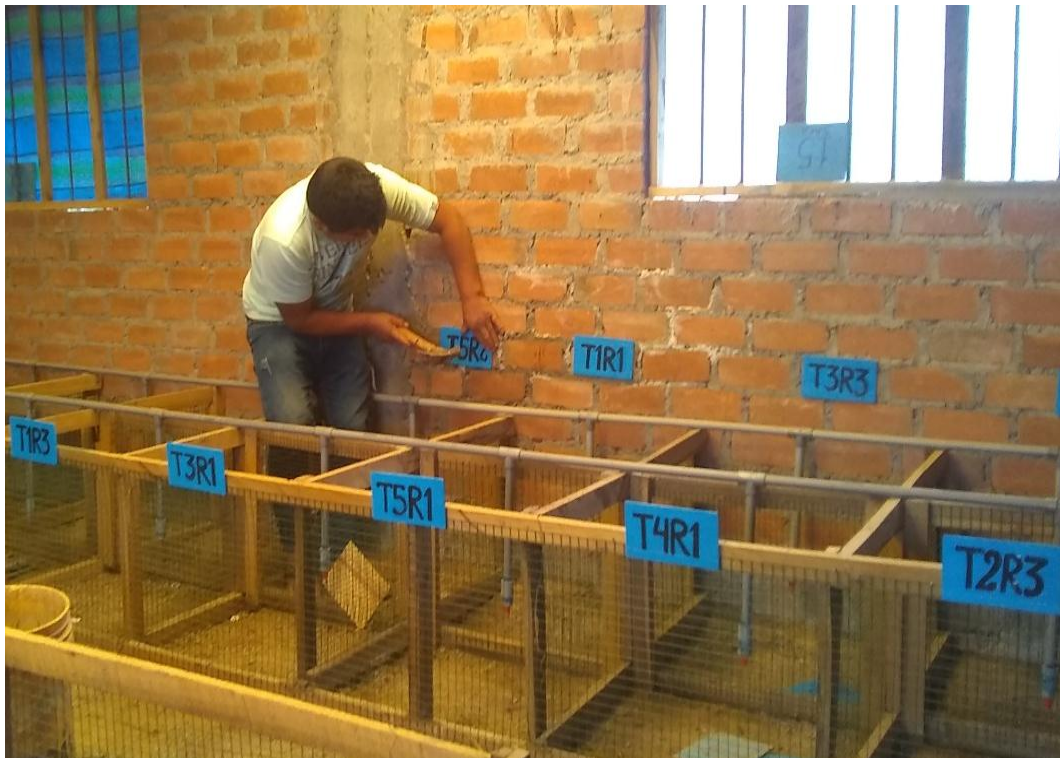
Fotografía 04: Acondicionamiento de las pozas del experimento
