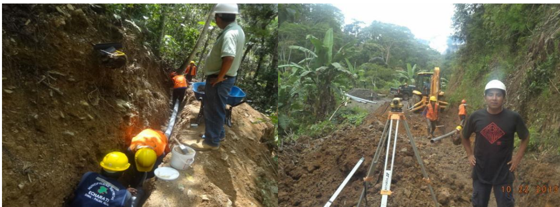
Figura 3.4. Instalación de tuberías de PVC – UF el empalme adecuado y colocación de camas.
