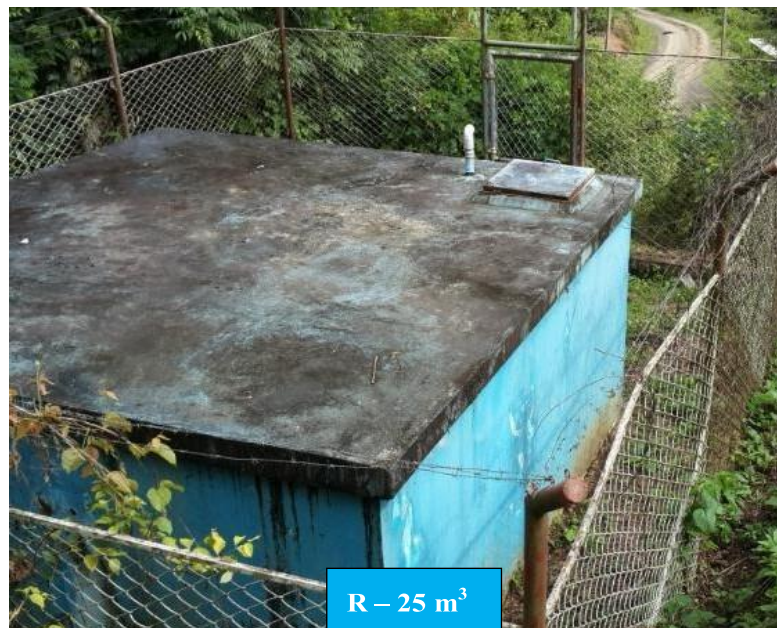
Figura 3.13. Reservorio encontrado de 25 m 3 .
