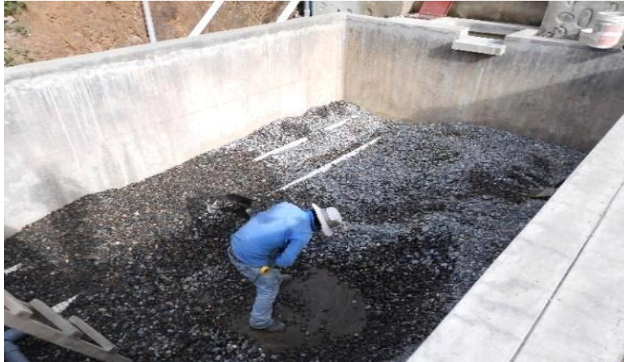
Figura 3.10. Llenado de capas de diferentes diámetros
