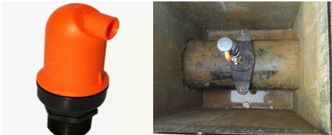
Figura 3.7. Vista de válvulas de aire en las partes altas según el plano longitudinal de línea de conducción.
