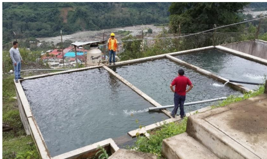
Figura 3.11. Construcción de 4° filtro lento concreto f_c: 210 \text{ kg/cm}^2 .
