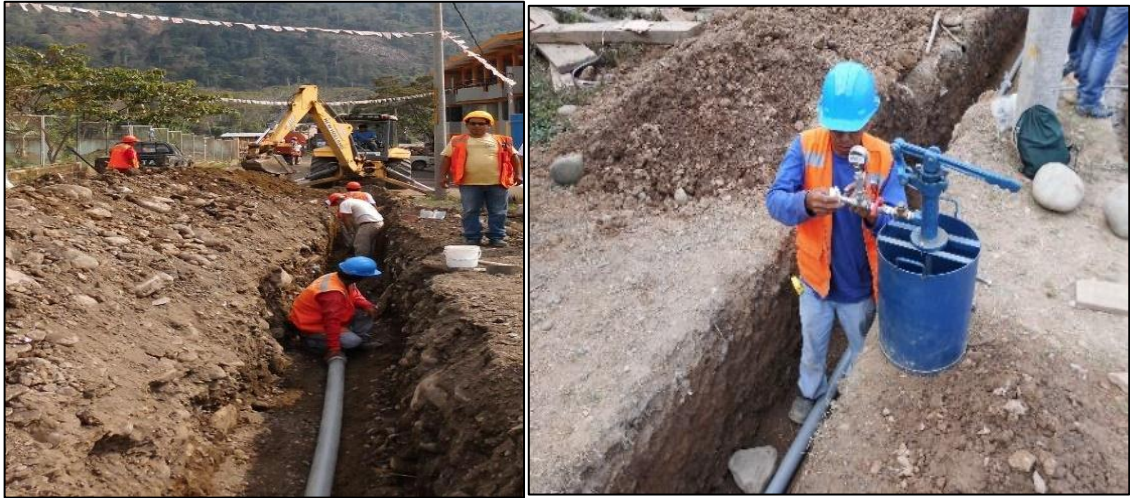
Figura 3.20. Prueba hidráulica en red de distribución
