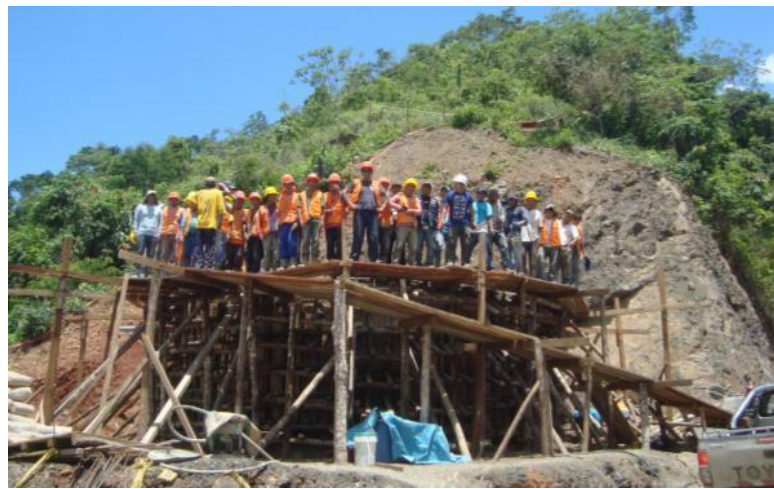
Figura 3.12. Personal de obra luego del vaciado en R-100 m
