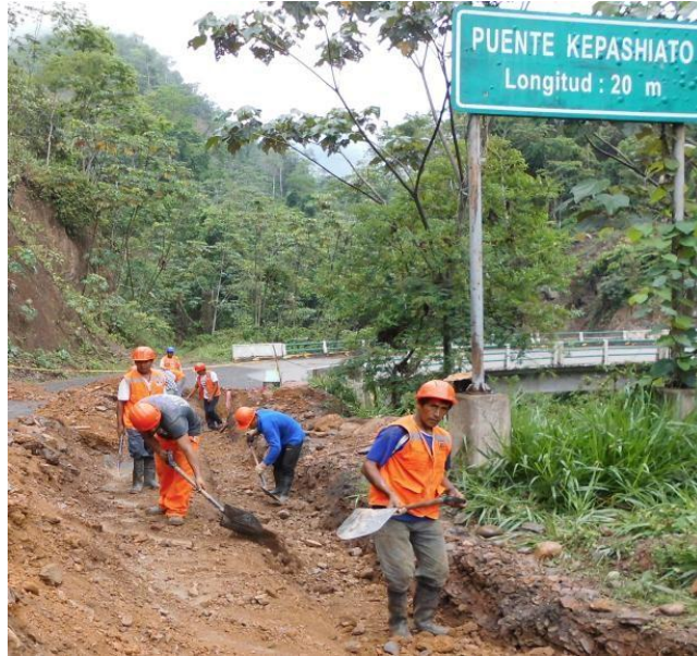
Figura 3.8. Excavación de zanja en tramos finales de red de distribución
