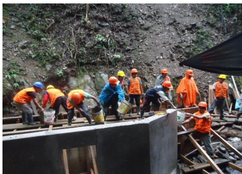
Figura 3.1. Vaciado de captación con personal de obra.
