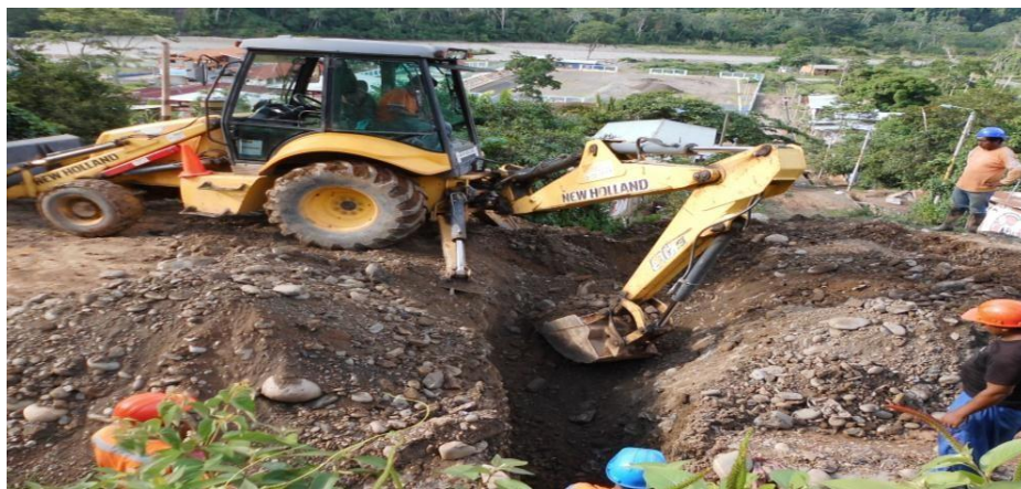
Figura 3.22. Excavaciones para tendido de tuberías con apoyo de retroexcavadora.
