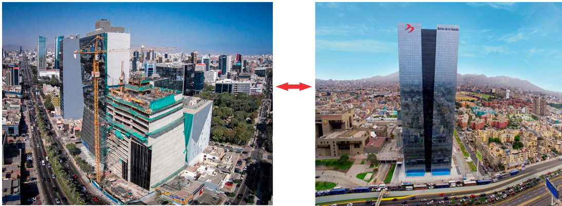
Figura 2.7: Proyecto del Banco de la Nación. Fuente GyM.
