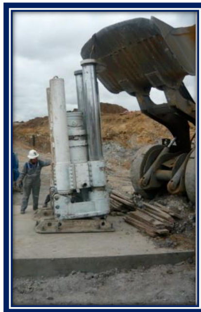
Figura 19 Instalación de máquina
