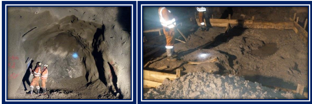
Figura 18 Cámara y encofrado de losa
