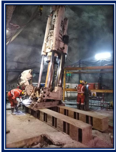
Figura 20 Instalación de vigas de acero
