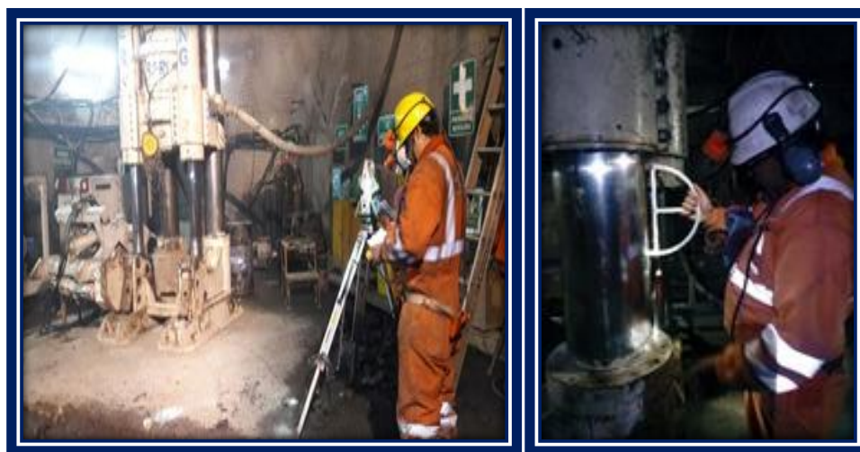
Figura 25 Nivelación de placa base
