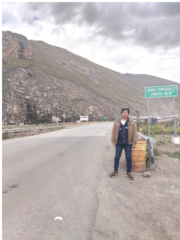
Figura 54 Puente Rumichaca. Fuente:Fotografía propia.
