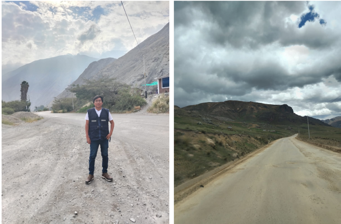
Figura 231 Estado de la Via Los Libertadores - Distr. Humay. Fuente: Fotografía propia
