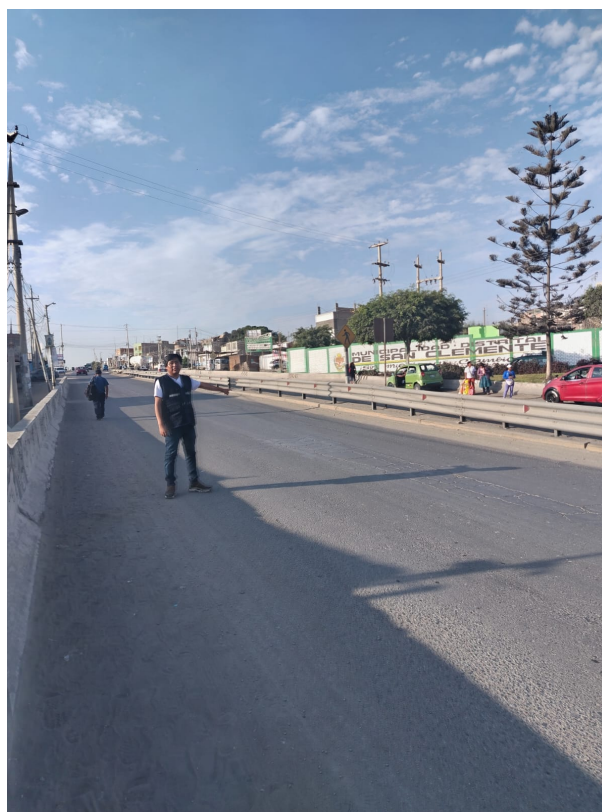
Figura 53 Progresiva 0+000km - Ica (distr. San Clemente)
