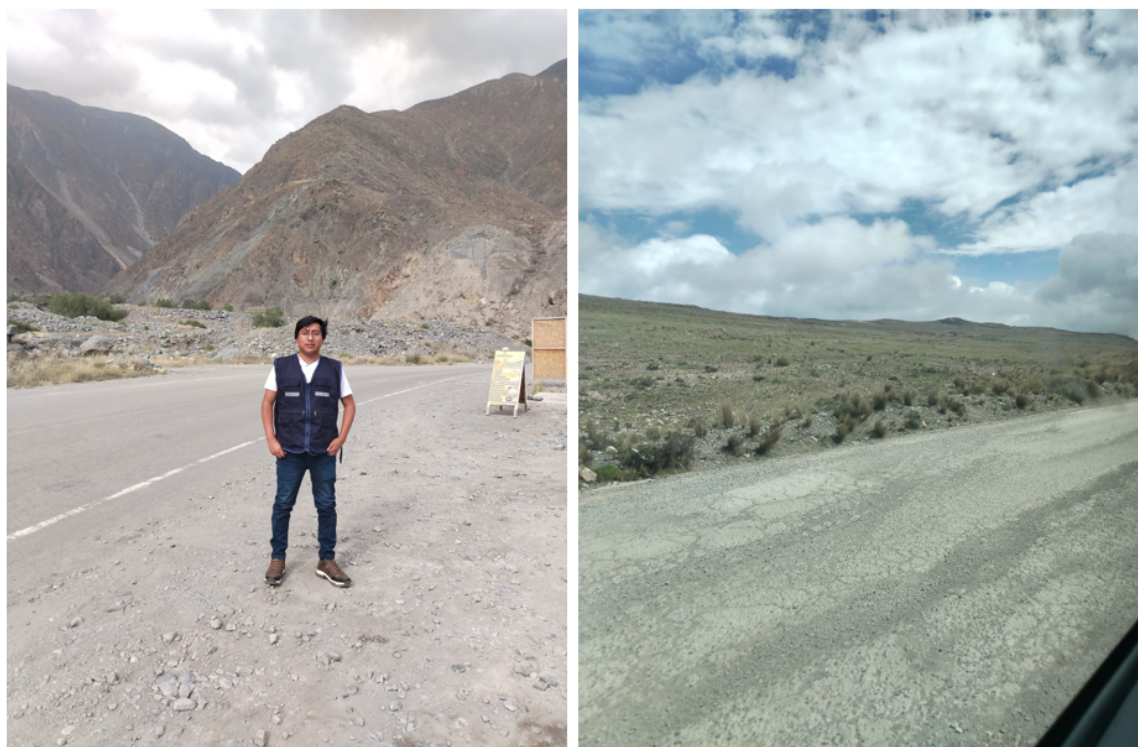
Figura 232 Estado de la Via Los Libertadores - Distr. Huancano. Fuente: Fotografía propia
