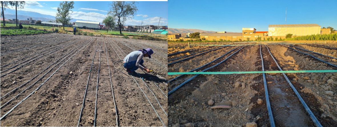
Foto 5. Instalación de cintas de riego
