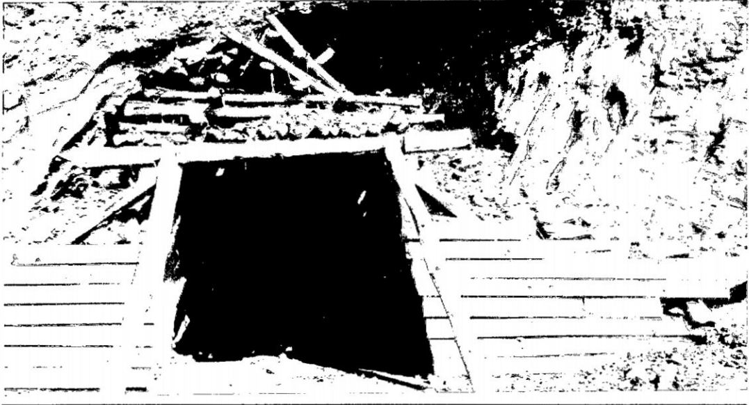
Fig.5 Protección con cuadros de madera en bocamina
