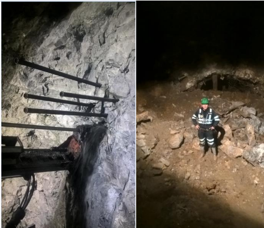
Figura N° 118: Control del Paralelismo Split Set - Tajo Minado.
