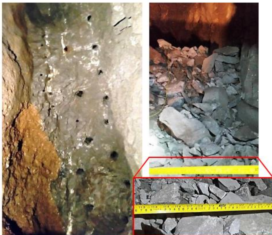
Figura N° 61: Resultado del disparo en el Tj. 693
