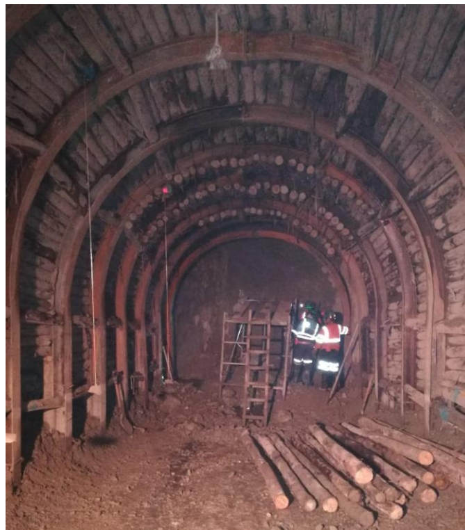
Figura N° 112: Armado de Cimbra H6 , Rp-798 (-15%).
