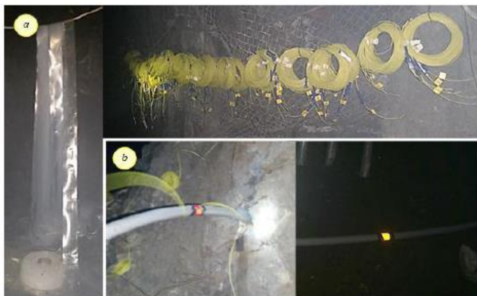
Figura N°70: Orden y limpieza en el proceso de carguío, Uso de marcas para el carguío de 60, 90 y 30%
