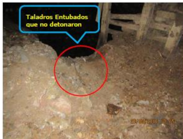
Figura N° 18: Resultados de la voladura
