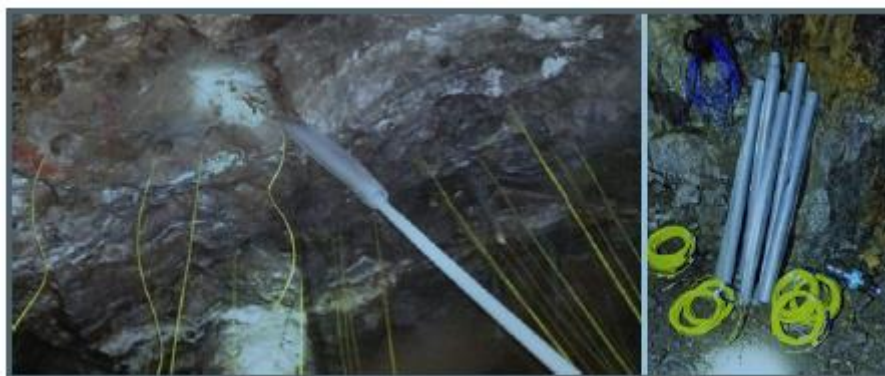
Figura N° 60: Aplicación del air deck en el tajo 693
