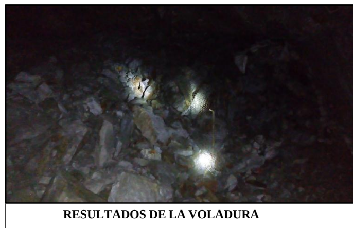
Figura N° 24: Vista de Voladura
