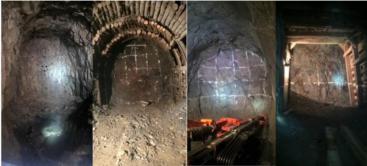
Figura N° 117: Perforación de Frentes.
