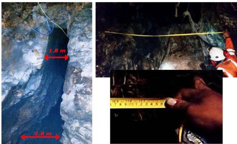
Figura N° 57: Disminución de la sobre-rotura de las cajas (reducción del % de dilución).
