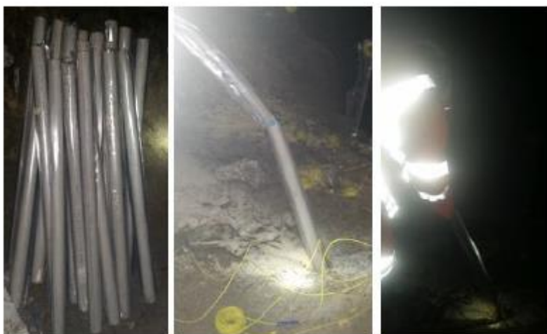
Figura N° 69: Uso de los air decks en el Tajo 684
