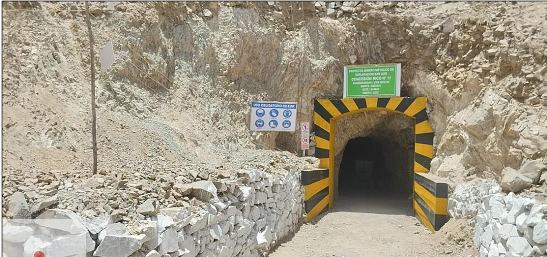
Figura39. Anexo4. Infraestructura: Bocamina y Acceso a la Galería 2235
