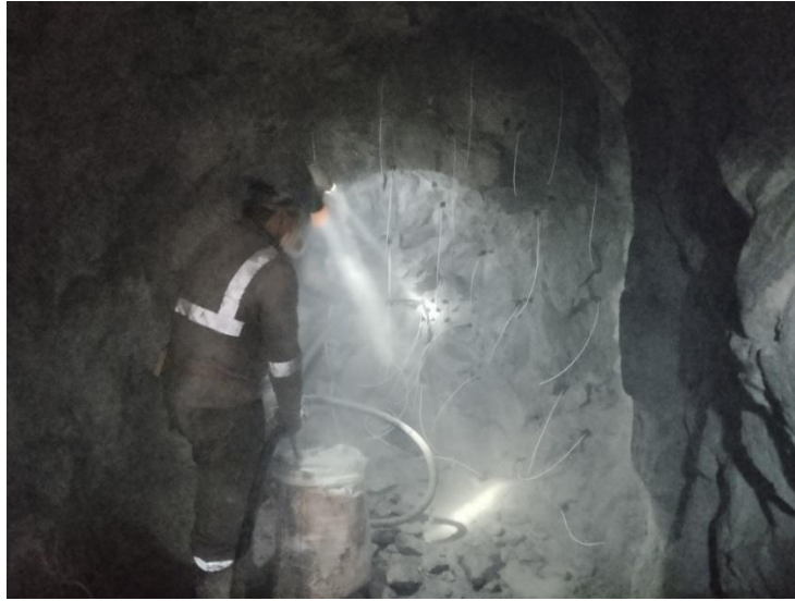
Figura43. Anexo7. Operación Unitaria de Perforación y Carguío de Taladros en Frente de Avance Galeria-Cortada 1.80x2.10
