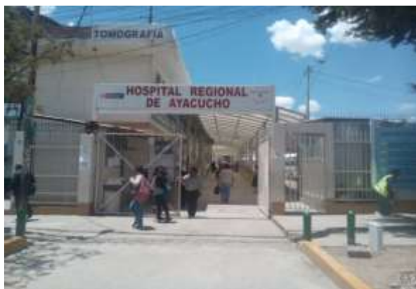
Figura 49 Foto del exterior del Hospital Regional de Ayacucho
